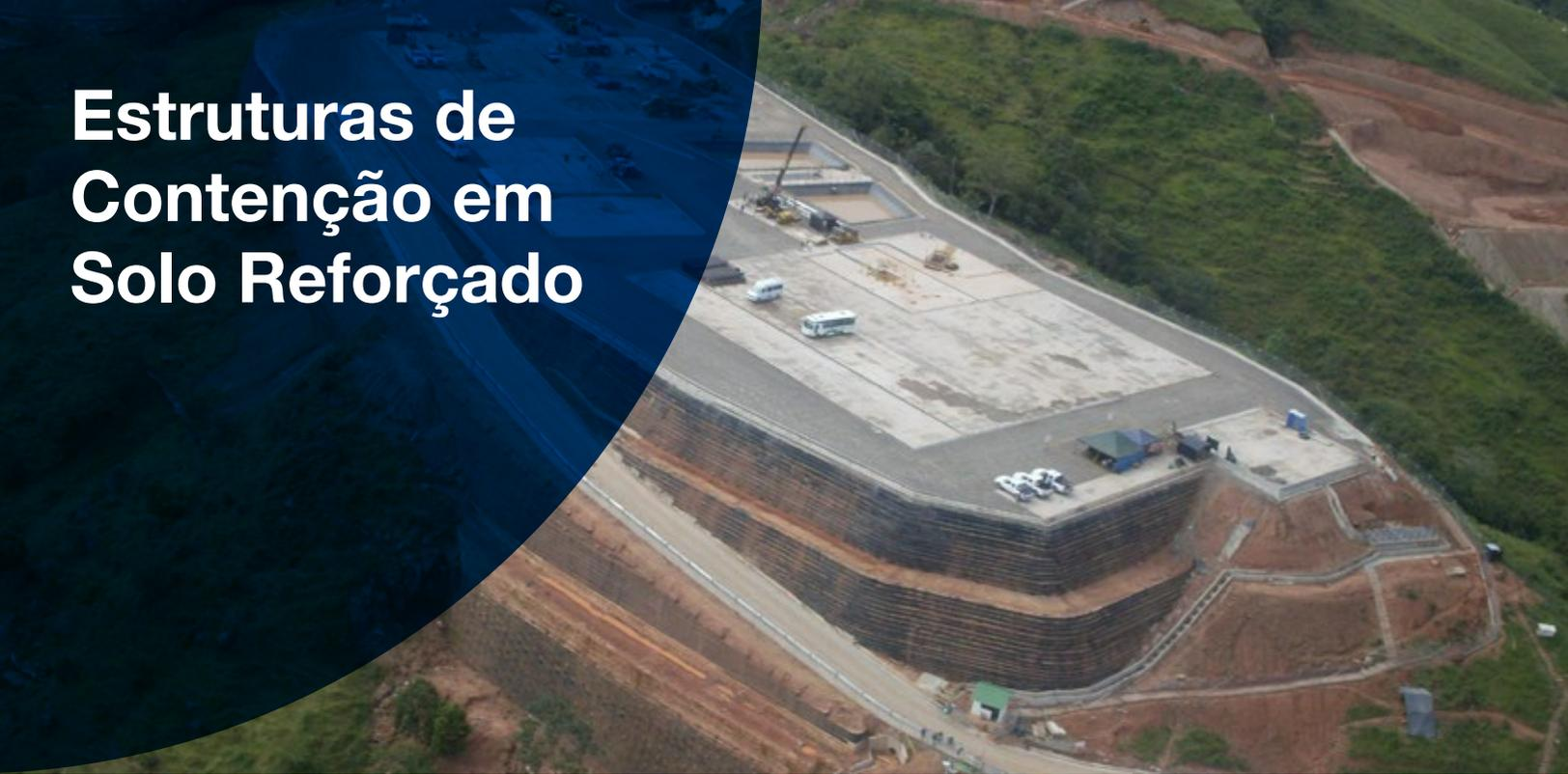
Estruturas de Contenção em Solo Reforçado permitem a construção e reforço de aterros e muros autoportantes que **garantem os critérios de segurança e estabilidade do projeto a médio e longo prazo.**
