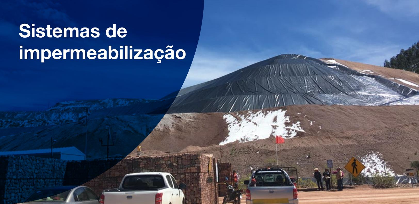
As práticas de mineração requerem um alto desempenho nos sistemas de revestimento para contenção de líquidos ou outros fluidos, o qual é obtido através da utilização de Geomembranas e GCL (Geosynthetic CLAY LINER), a fim de proteger os recursos subterrâneos e o lençol freático para evitar sua contaminação, se utilizam na recuperação de produtos químicos.
