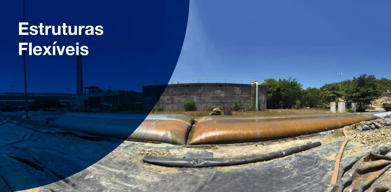
Estruturas Flexíveis são geofomas de diferentes dimensões fabricadas com Geotêxteis Tecidos de alta desempenho, que **se adaptam às condições especiais de cada projeto**. Essas estruturas podem ser preenchidas com diferentes materiais disponíveis na obra e podem ser instaladas em condição seca ou submersa. A dimensão e o tipo de estrutura dependem da sua aplicação, processo construtivo e tipo de projeto. Como soluções alternativas contamos com:
