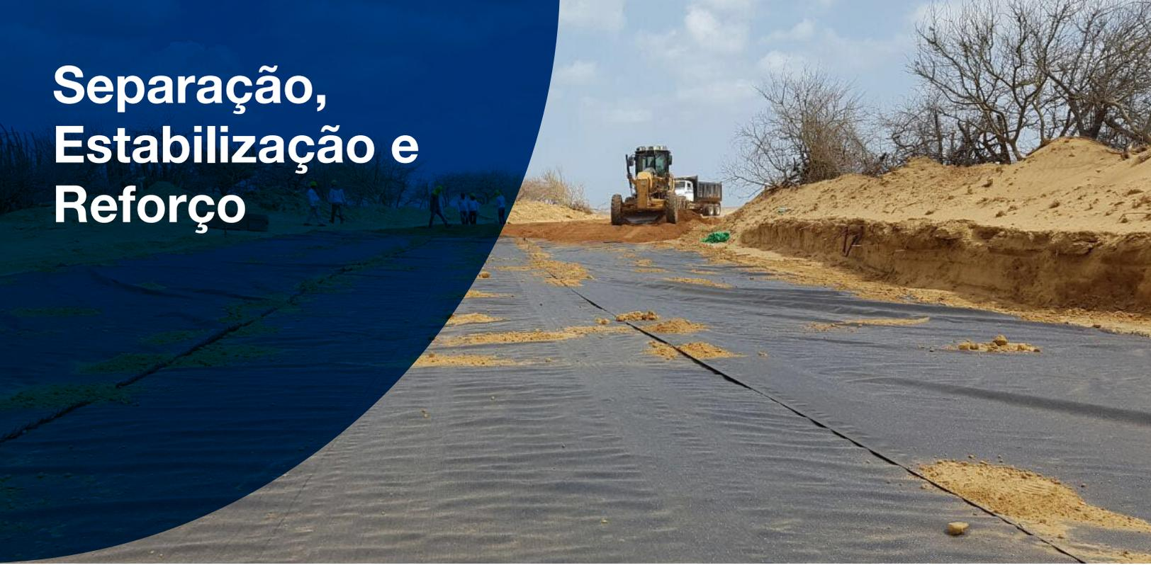
As atividades de extração e processamento mineiro ocorrem, em geral, em áreas remotas que requerem a construção de caminhos de acesso e plataformas de trabalho estáveis e seguras, frequentemente em locais com baixa capacidade de suporte. Para permitir a construção de tais vias, pode-se utilizar **Geossintéticos com diferentes funções para a separação de materiais, estabilização de subleito e reforço de camadas granulares**.
