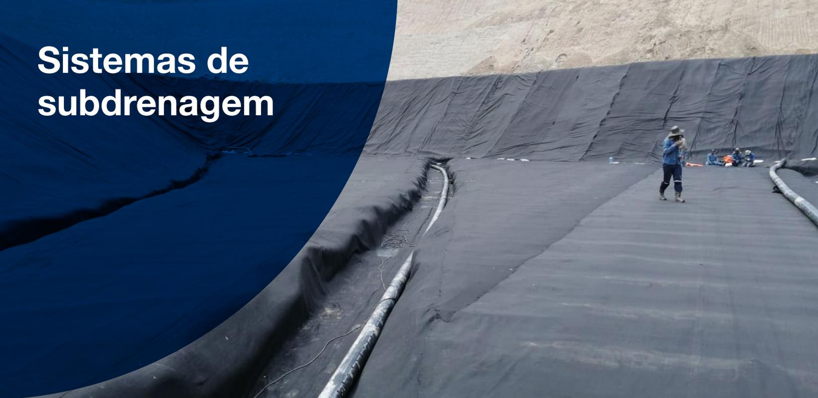
Os geocompostos de drenagem **são necessários em todas as etapas do processo mineiro**, desde a necessidade de deságues nas estradas de acesso, processamento do mineral, drenagem interna e externa das barragens de rejeito, almofadas de lixiviação, piscinas e conduções para um adequado fechamento mineiro.
