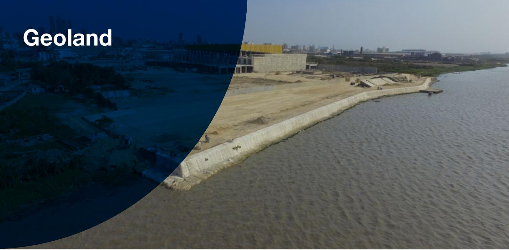
É um sistema flexível desenvolvido a partir de uma combinação apropriada de Geossintéticos. **Permite a geração de áreas planas, mediante a ampliação, recuperação ou construção de espaços em terrenos montanhosos ou na presença de corpos d'água.** É uma solução durável ao longo do tempo e que conta com uma proteção para o controle de erosão.
