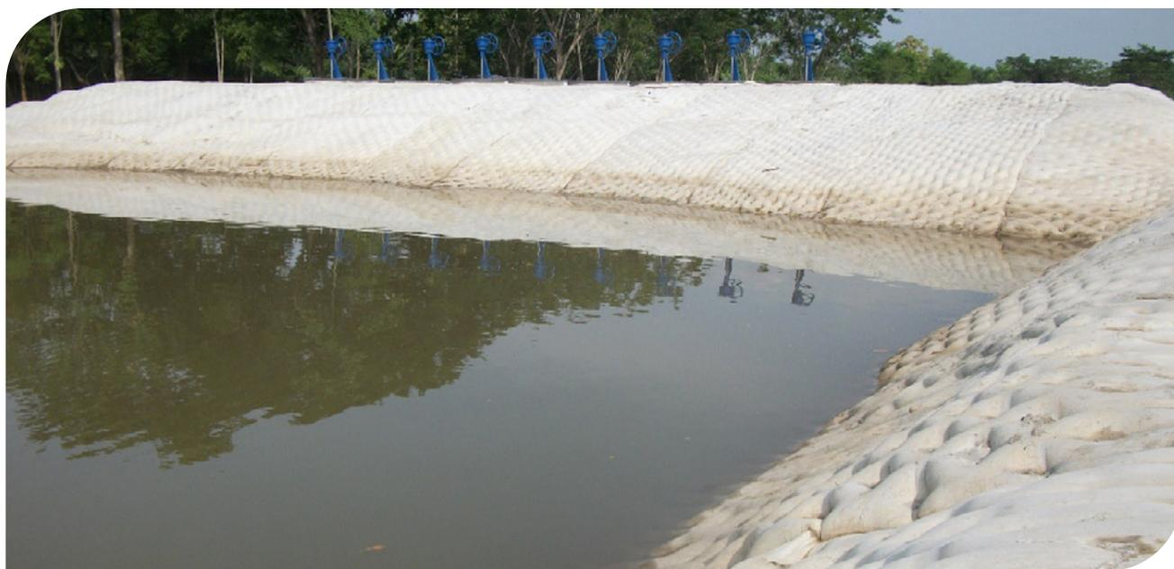
▲ Fotografía 17.37 | Flexocreto instalado proyecto Hidrosogamoso, Ciénaga el Llanito, ISAGEN.
