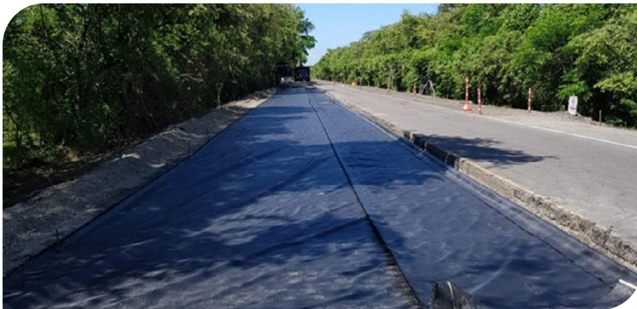
▲ Imágen 7.1 | Extensión Geotextil de separación. Autovía Neiva Girardot, Colombia.
