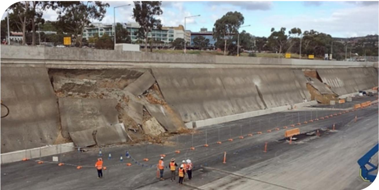
▲ *Fotografía 16.11 | Falla en protección con concreto lanzado. Foto de Tony Lewis.*
