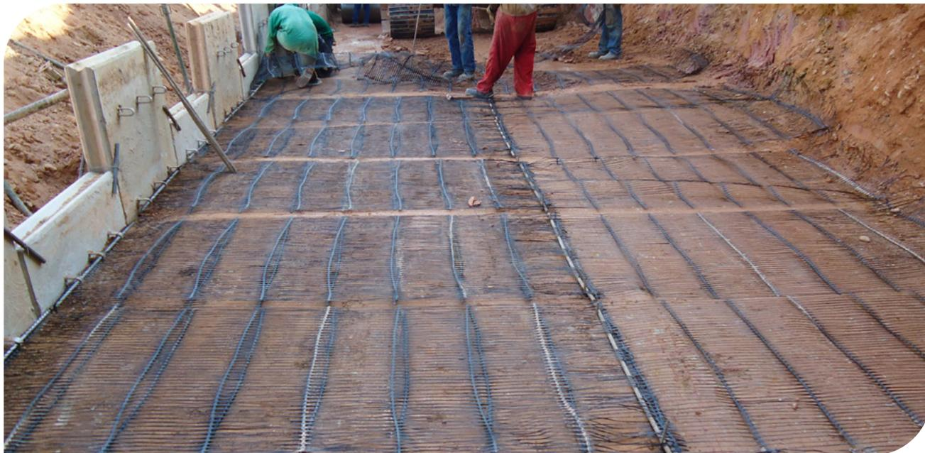
▲ *Fotografía 11.10 | Fachada en paneles en escamas de concreto, como estructura pegada al muro en suelo reforzado con Geomalla.*
