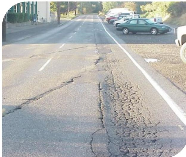
Imagen 8.2 | Piel de cocodrilo acompañada de ahuellamiento (der.) Severidad alta.<sup>1</sup>
