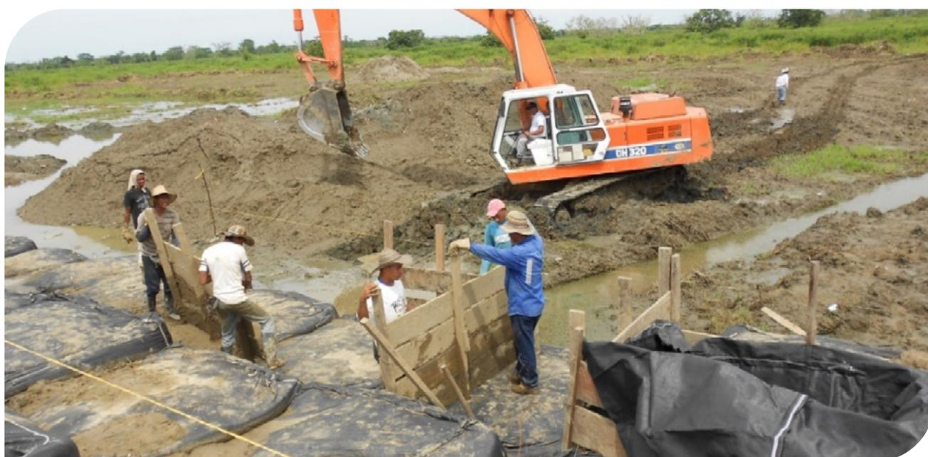
▲ Fotografía 17.13 | Instalación de Geobox de Geotextil TR4000.
