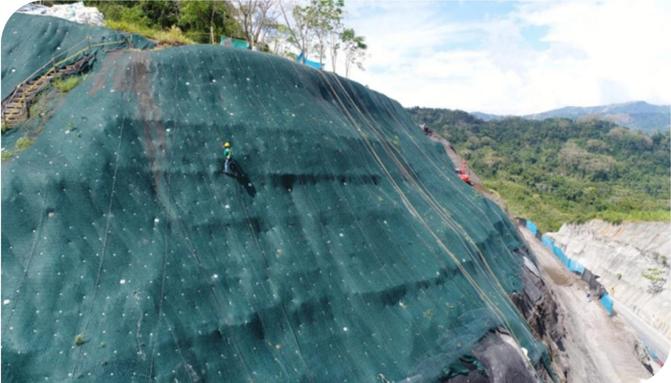
▲ *Fotografía 16.8 | G-Green: Manto – malla talud. Perfil con erosión diferencial.*
