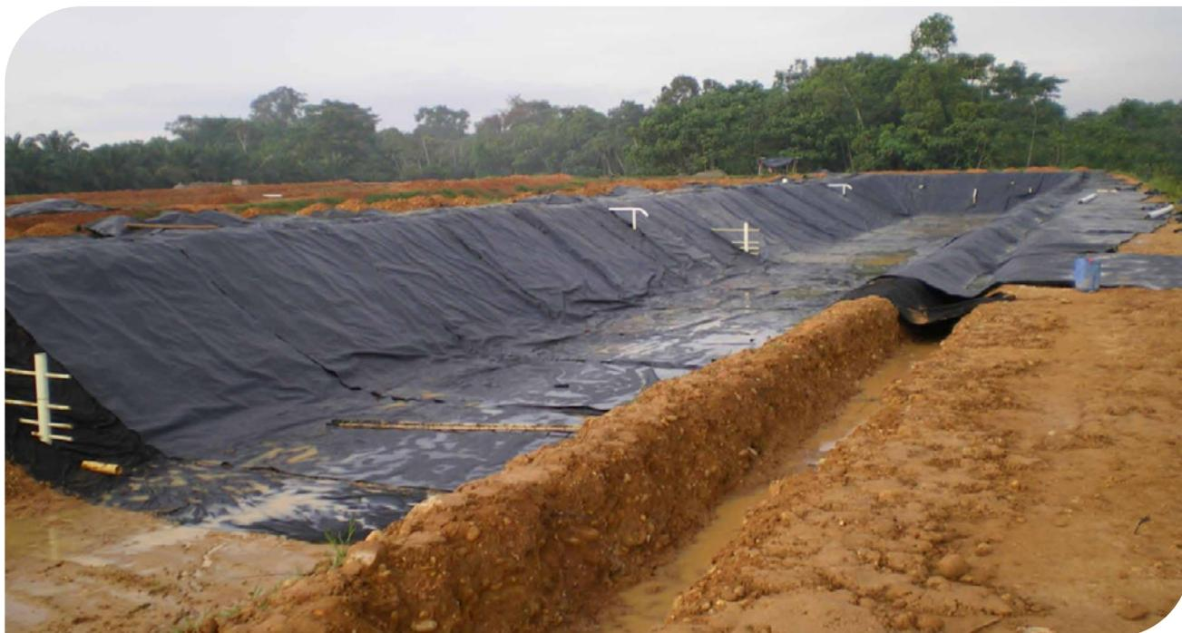
▲ *Instalación Geotextil No Tejido para protección de Geomembrana | Santander - 2009.*
