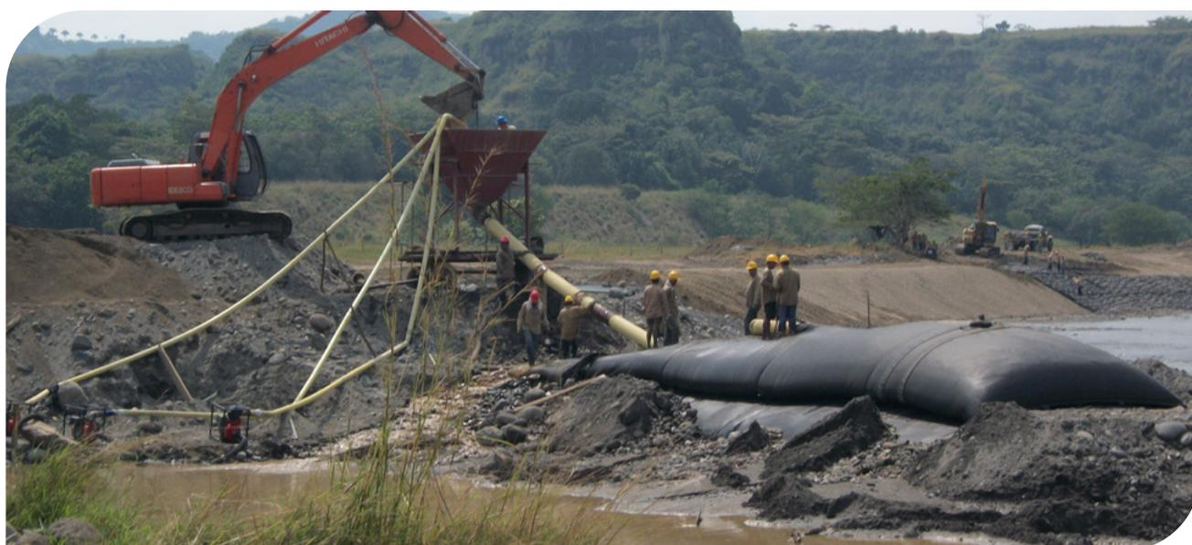
▲ Fotografía 17.18 | Llenado de Geotextile Tubes por gravedad.
