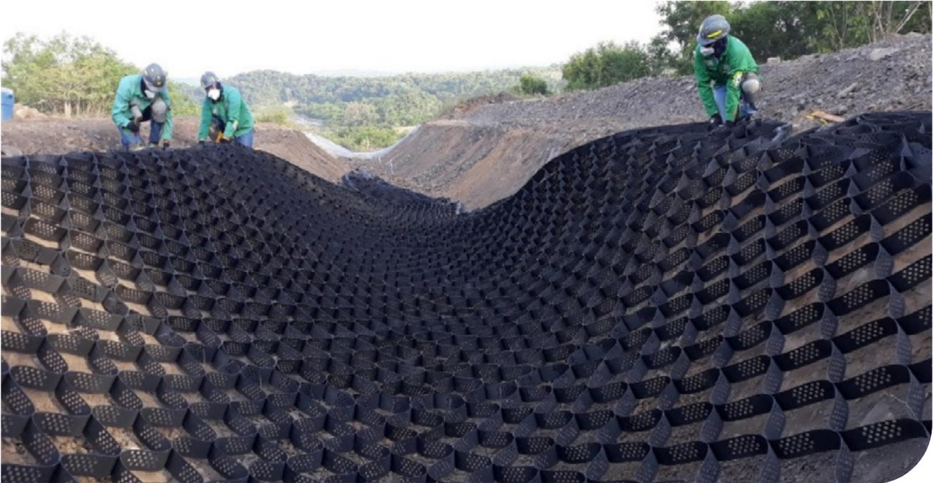
▲ Fotografía 17.44 | Protección de un canal con Geocelda.
