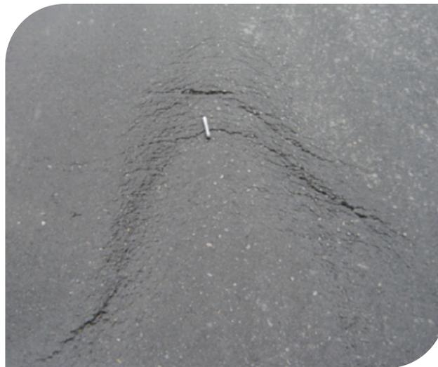
*Imagen 8.8 | Fisuración por deslizamiento de capas.*<sup>3</sup>
