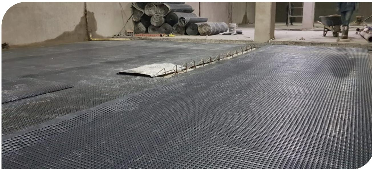
▲ Sistema de drenaje en cimentaciones con TecDren | Edificio Sigma, Bogotá, Colombia.
