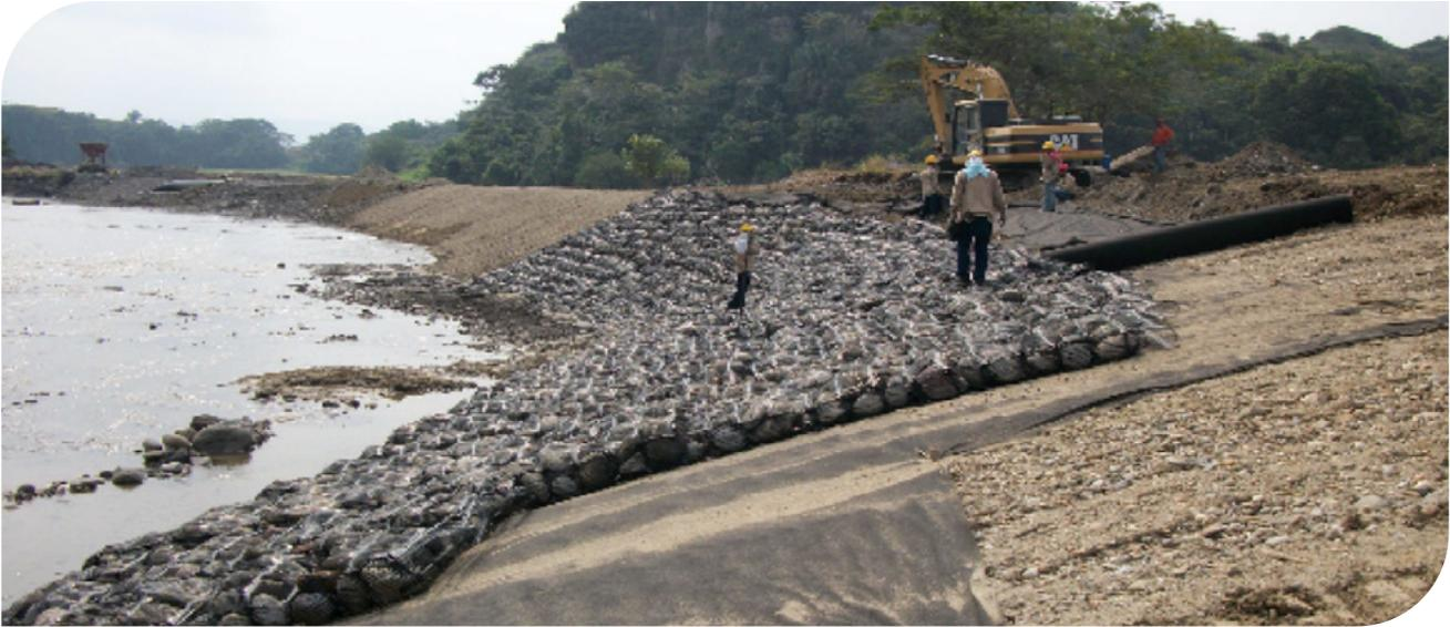
▲ *Fotografía 17.25 | Sistema para control de erosión y socavación mediante Geocolchón y Geotextil No Tejido.*
