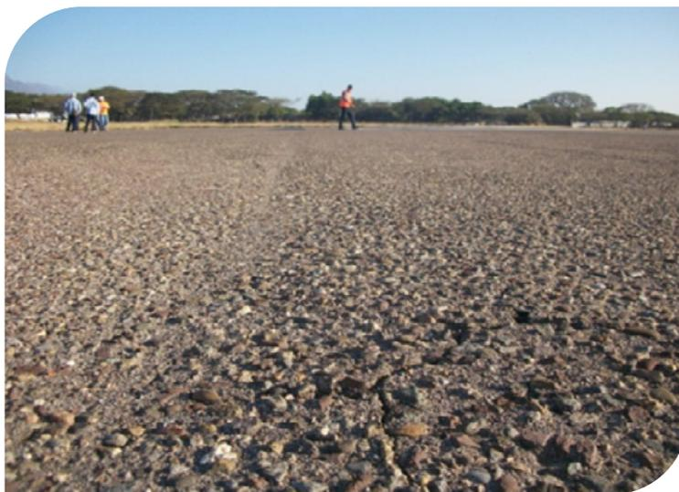
▲ *Imagen 8.23 | Capa de rodadura envejecida, oxidada, agrietada con presencia de cabezas duras, que requiere capa de nivelación previa para lograr mejor adherencia de una Geomalla de Fibra de Vidrio.*
