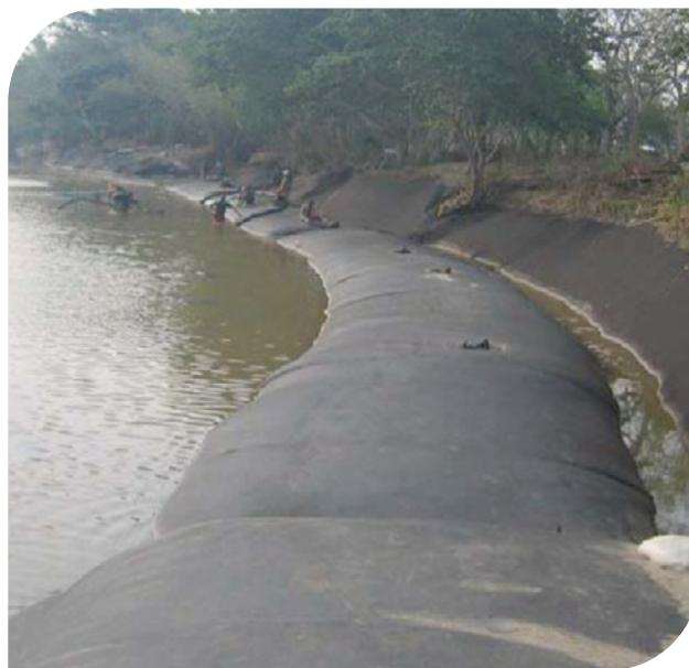
▲ Fotografías 17.23 - 17.24 | Geotextile Tubes instalados.
