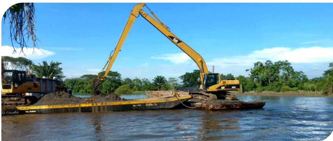
▲ *Fotografía 17.58 | Excavación y adecuación del terreno bajo agua para la instalación de Geobags Estructura hidráulica San Silvestre Barrancabermeja - Santander Colombia, tomada del Consorcio Obras San Silvestre.*
