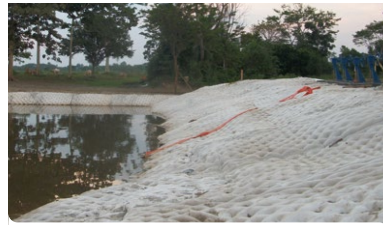
▲ Proteção de estruturas hidráulicas
