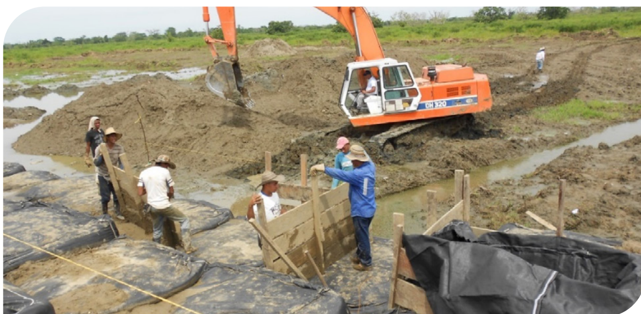
▲ Fotografia 17.13 | Instalação de Geobox de Geotêxtil TR4000.
