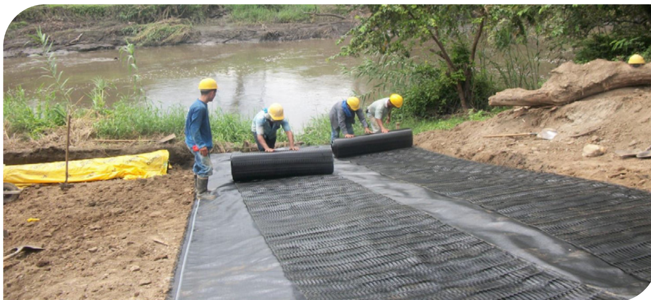
▲ Fotografia 17.29 | Estendido de Geogrelha sobre Geotêxtil Não Tecido.
