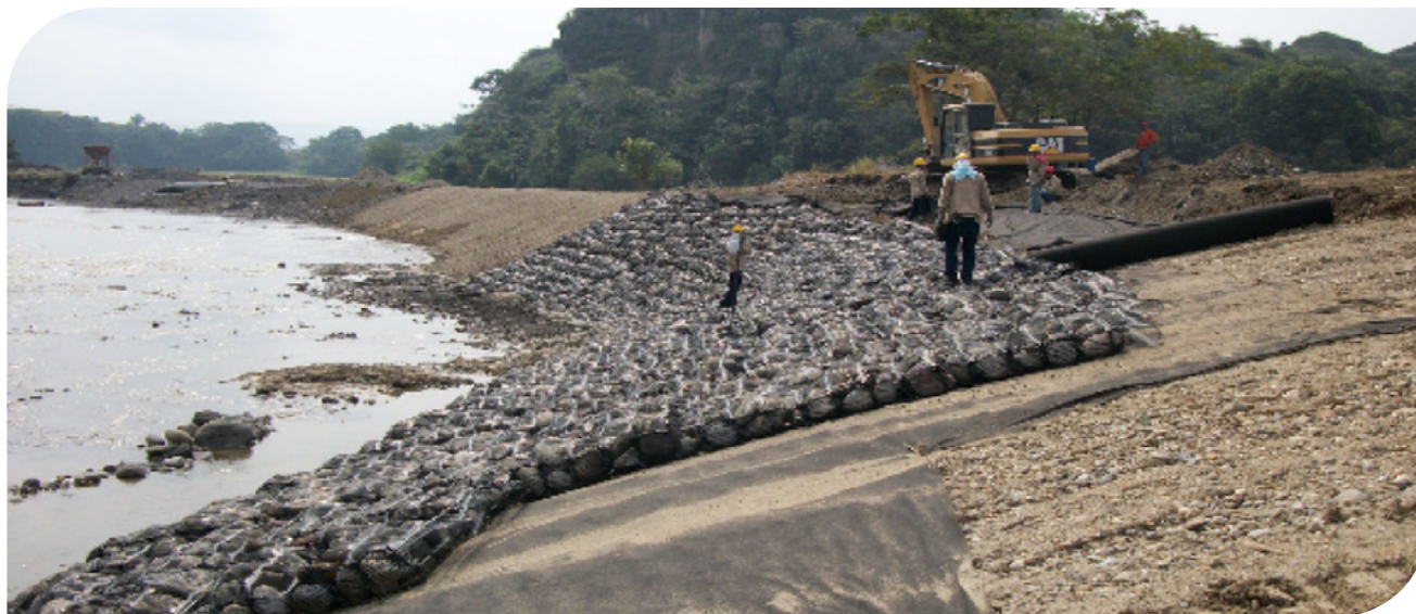
▲ Fotografia 17.25 | Sistema para controle de erosão e socavação mediante Geocolchão e Geotêxtil Não Tecido.
