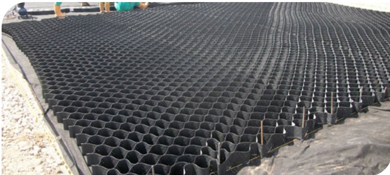
▲ Imagem 7.2. | Barras de suporte para a instalação das Geocélulas.
