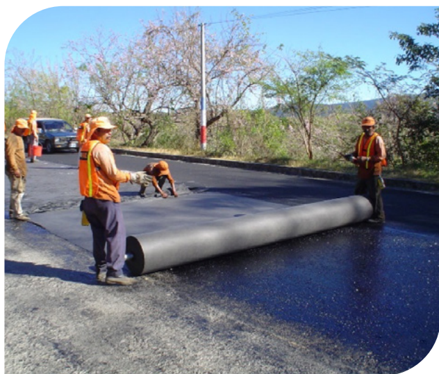
▲ Imagem 8.33 | Instalação manual dos rolos do Geotêxtil de Repavimentação..
