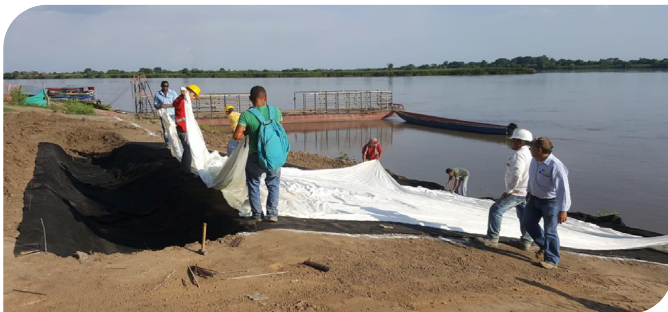
▲ Fotografia 17.41 | Instalação do Flexocreto - projeto Tamalameque, departamento de Centro, Colômbia.
