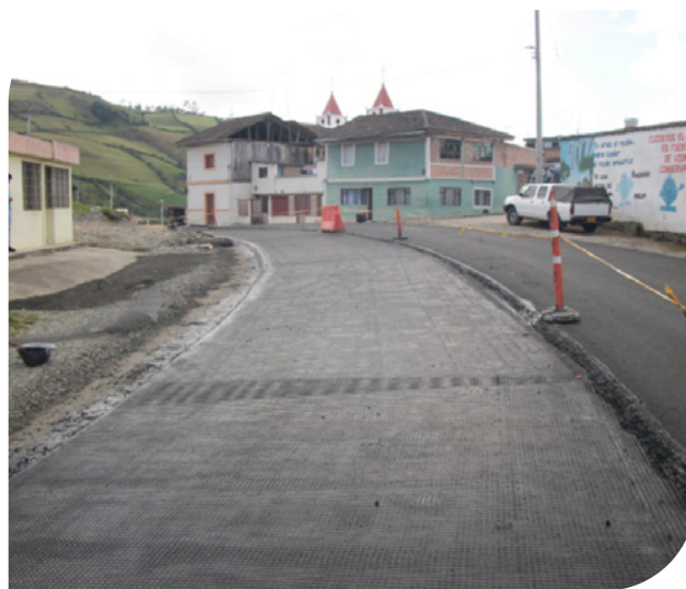
▲ Imagem 8.42 | Instalação de Geogrelha em curva em fase de recorte. Imagem 8.43 | Instalação de Geogrelha de Fibra de Vidro em curva terminada.
