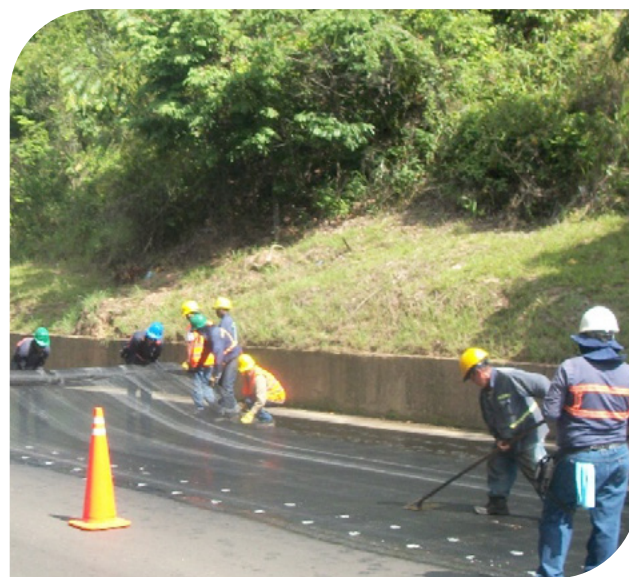
▲ Imagem 8.40 | Instalação manual dos rolos da Geogrelha de Fibra de Vidro.
