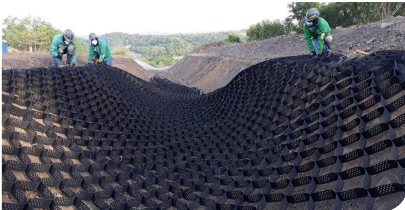
▲ Fotografia 17.44 | Proteção de um canal com Geocélula.
