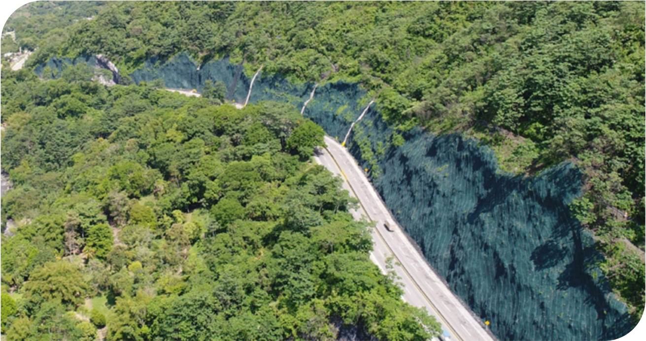
▲ Fotografia 16.1 | Sistema G- Green. Local crítico KM60 Bogotá Villeta.
