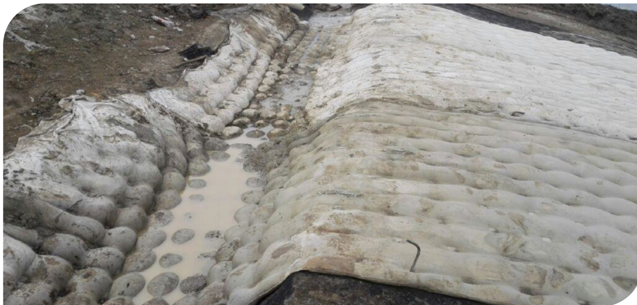
▲ Fotografia 17.42 | Preenchimento da vala de ancoragem, projeto Tamalameque, departamento de Centro.
