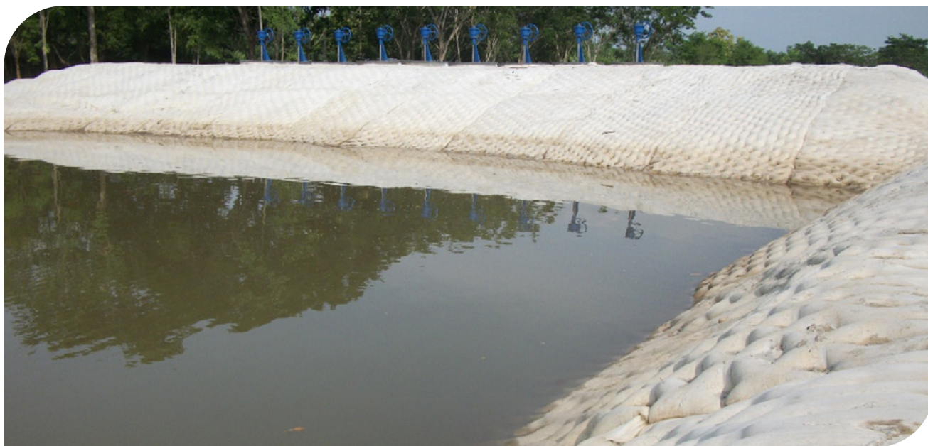
▲ Fotografia 17.37 | Flexocreto instalado projeto Hidrosogamoso, Pântano el Llanito, ISAGEN.
