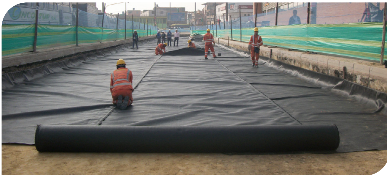
▲ Separação e estabilização com Geotêxtil Tecido | Via Patio Bonito, Bogotá, Colômbia.
