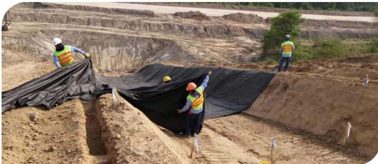
▲ Fotografia 17.46 | Conformação Vala de Ancoragem.
