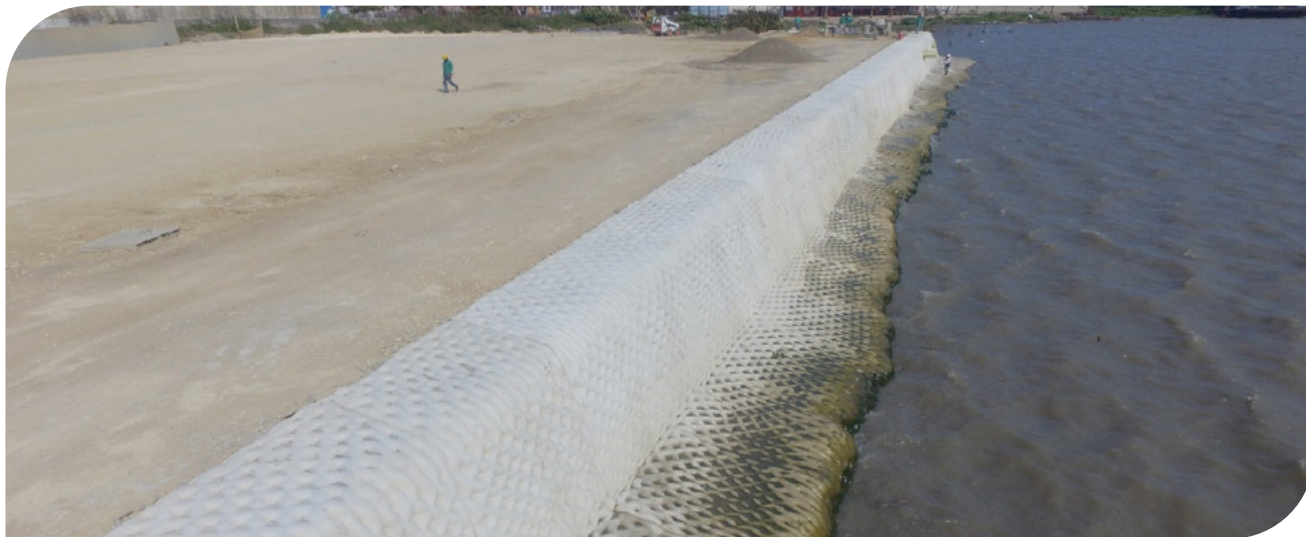
▲ Fotografia 17.53 | Cais do Centro de Eventos e Exposições do Caribe Barranquilla Atlântico, Colombia, construído pelo Consórcio Obras CEEC 2015.
