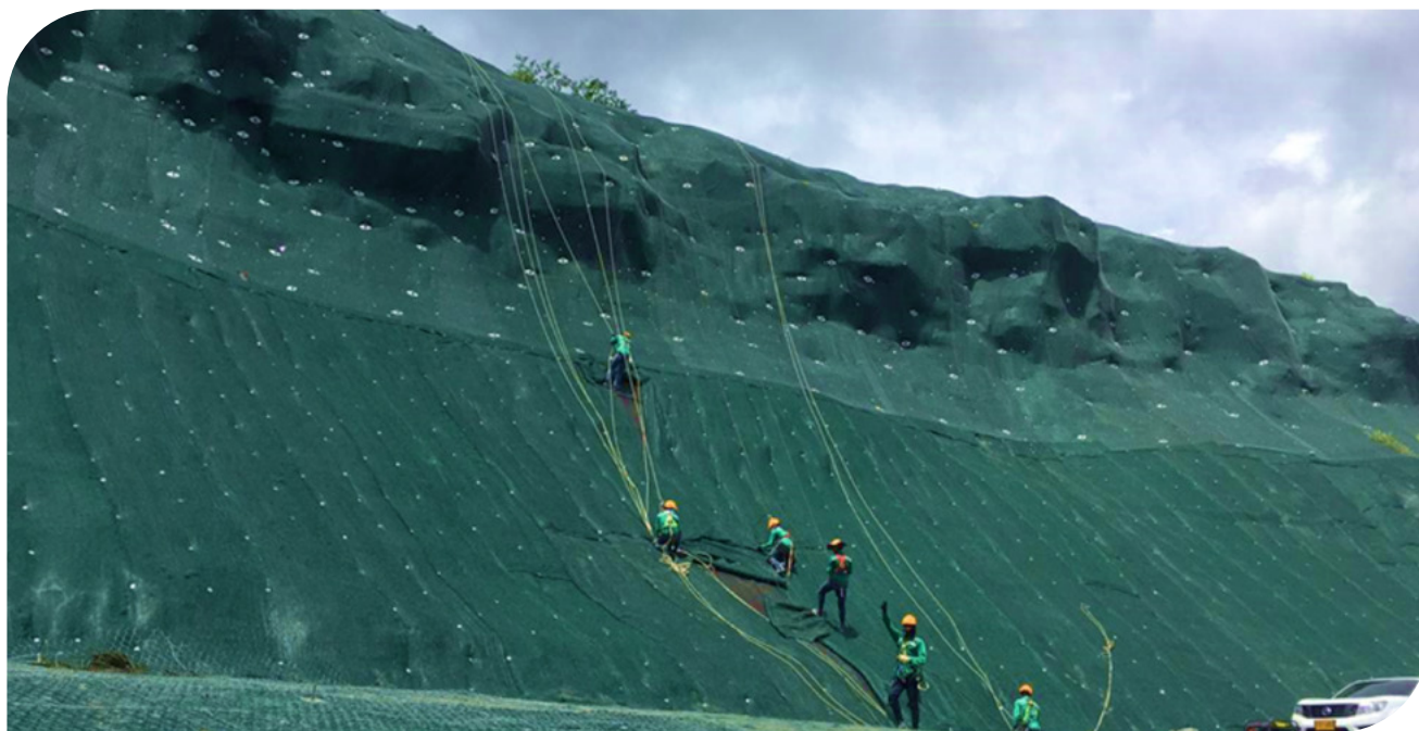
▲ Fotografia 16.7 | G-Green: Manto - malha talude. CES - ISAGEN.
