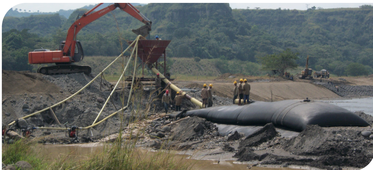
▲ Fotografia 17.18 | Preenchimento de Tubos de Geotêxtil por gravidade.
