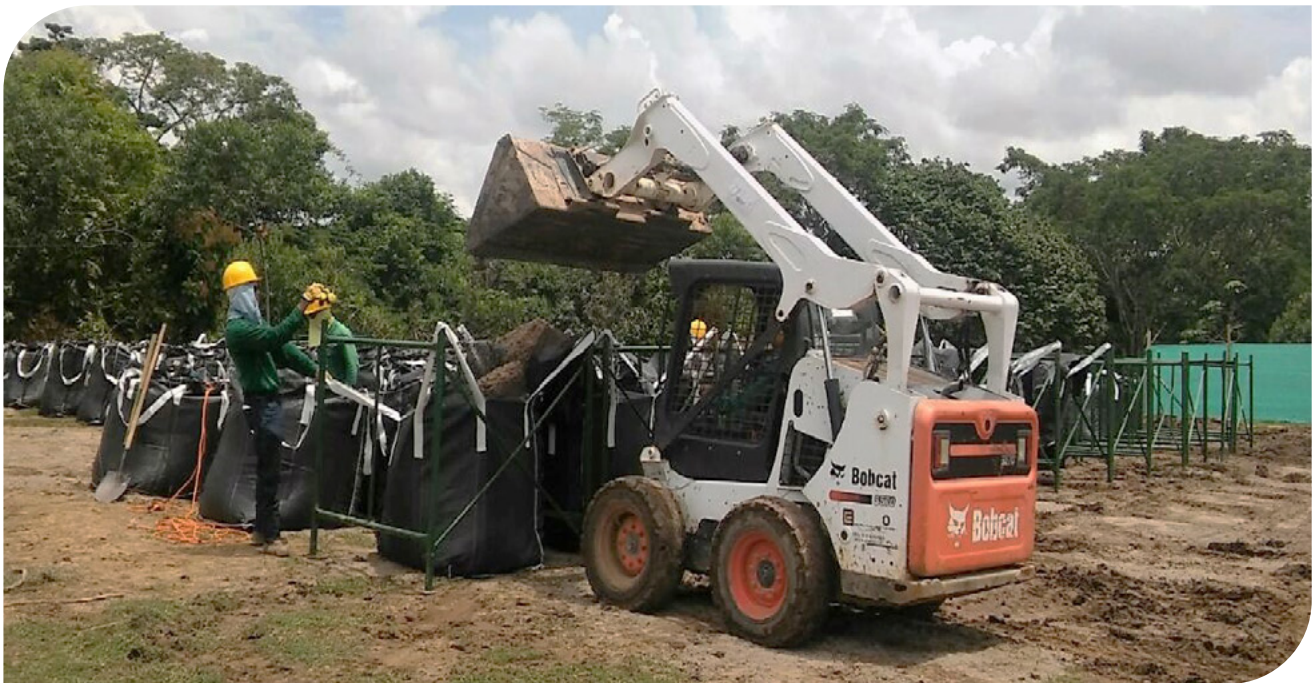
▲ Fotografia 17.6 | Preenchimento de Geobags com minicarregadeira.
