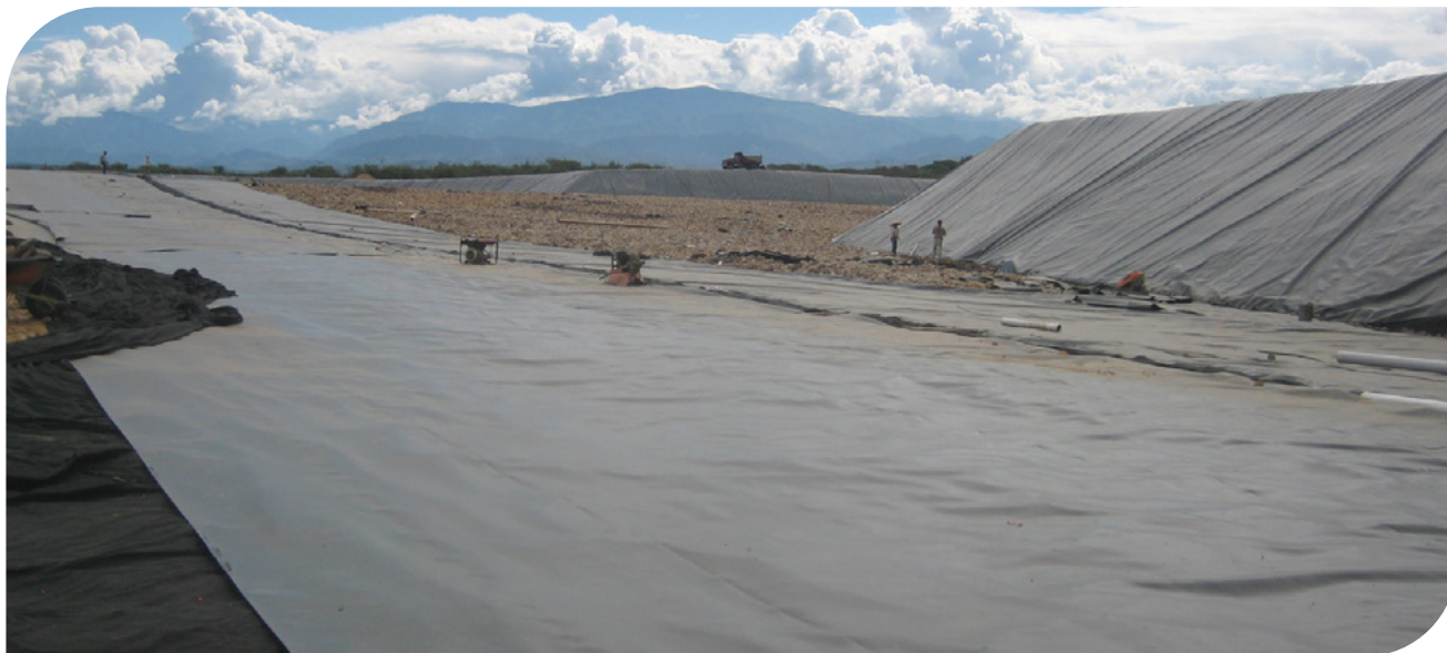
▲ Impermeabilização de aterro sanitário com Geomembrana PEAD | Aterro sanitário Lo Ángeles, Neiva, Colômbia
