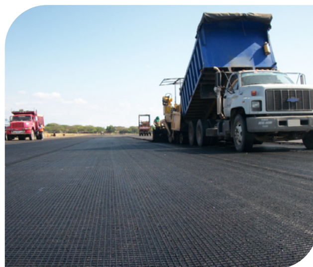
▲ Imagem 8.17 | Repavimentações com Geogrelha de Fibra de Vidro, Estrada 14 Armenia.
