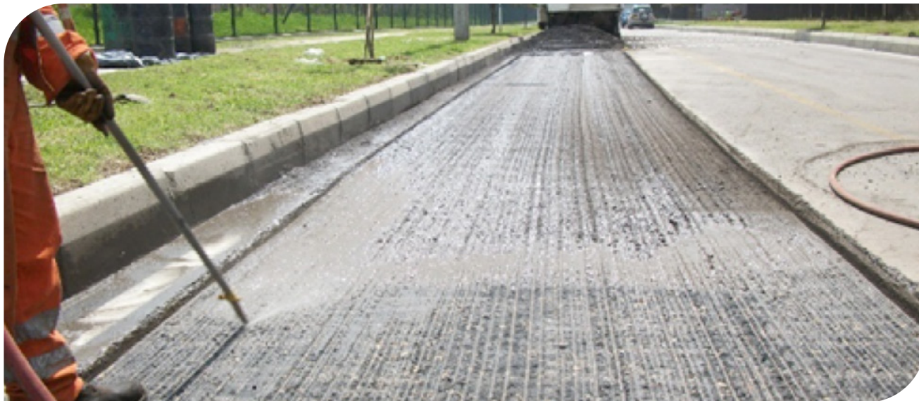
▲ Imagem 8.30 | Sopros com compressor de superfície fresada. Ciudad Verde, Soacha, Colômbia.
