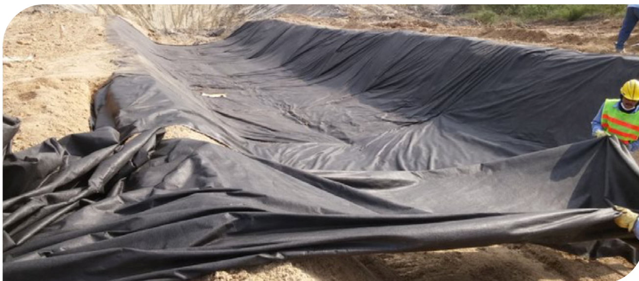
▲ Fotografia 17.47 | Instalação do Geotêxtil.
