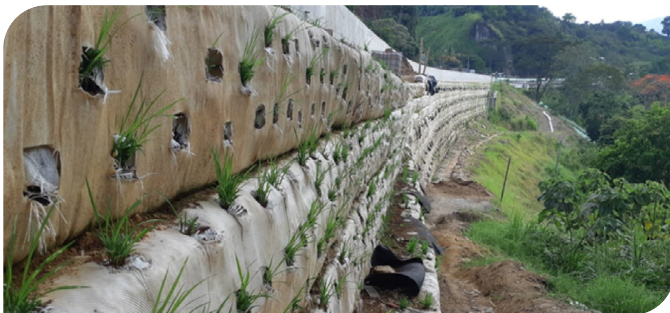
▲ Fotografia 11.12 | Fachada protegidas com Mantos Permanentes TRM.
