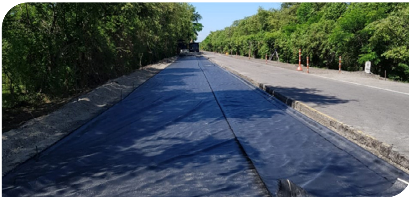
▲ Imagem 7.1 | Extensão Geotêxtil de separação. Autovía Neiva Girardot, Colômbia.
