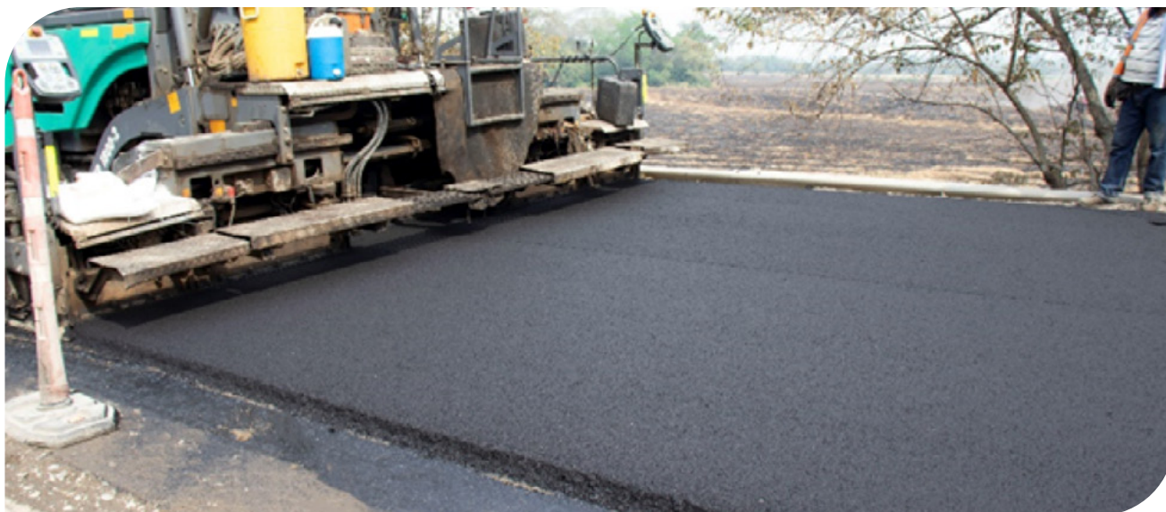
▲ Imagem 7.7 | Execução Concreto Asfáltico. Autovía Neiva Girardot, Colômbia.
