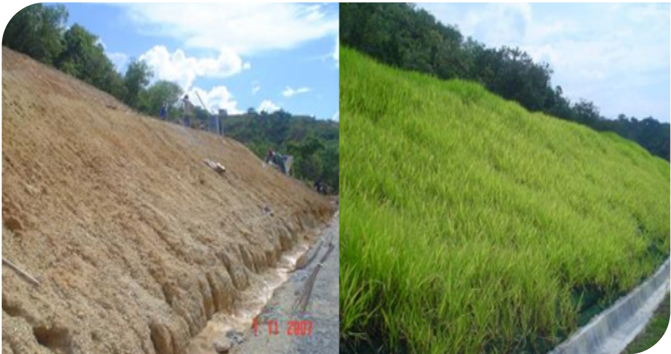
▲ Figura 16.3 | Proteção de Taludes – Biotecnologia.
