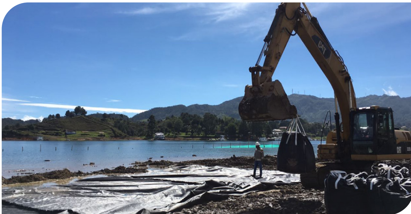
▲ Fotografia 17.59 | Instalação de Geotêxtil de reforço em um cais turístico de Guatapé Antioquia Colômbia, construído pela União Temporária de Obras Guatapé.
