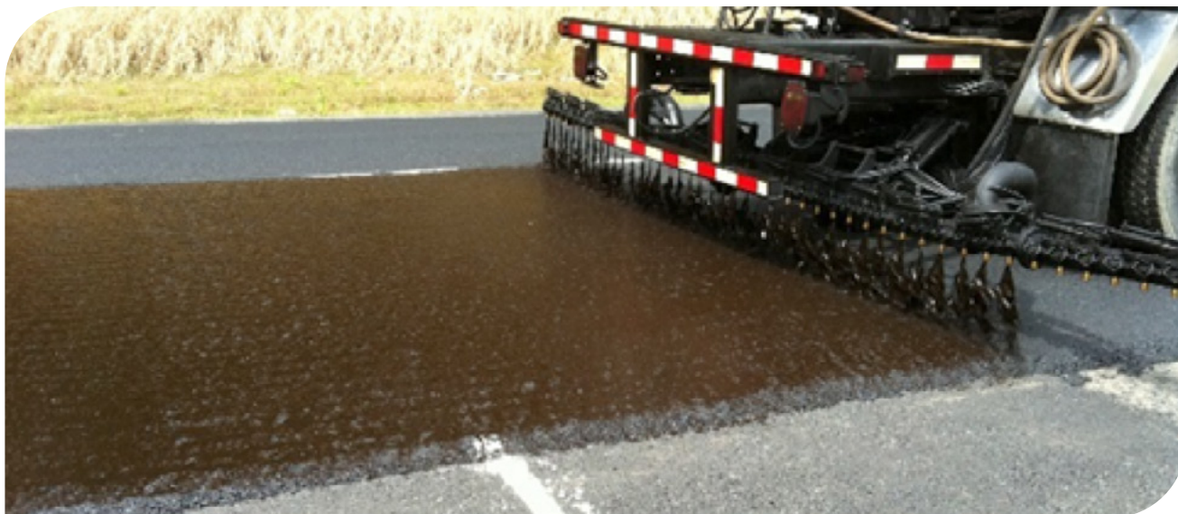
▲ Imagem 8.32 | Risco de emulsão com equipamento irrigador-dosificador. Costa Rica.
