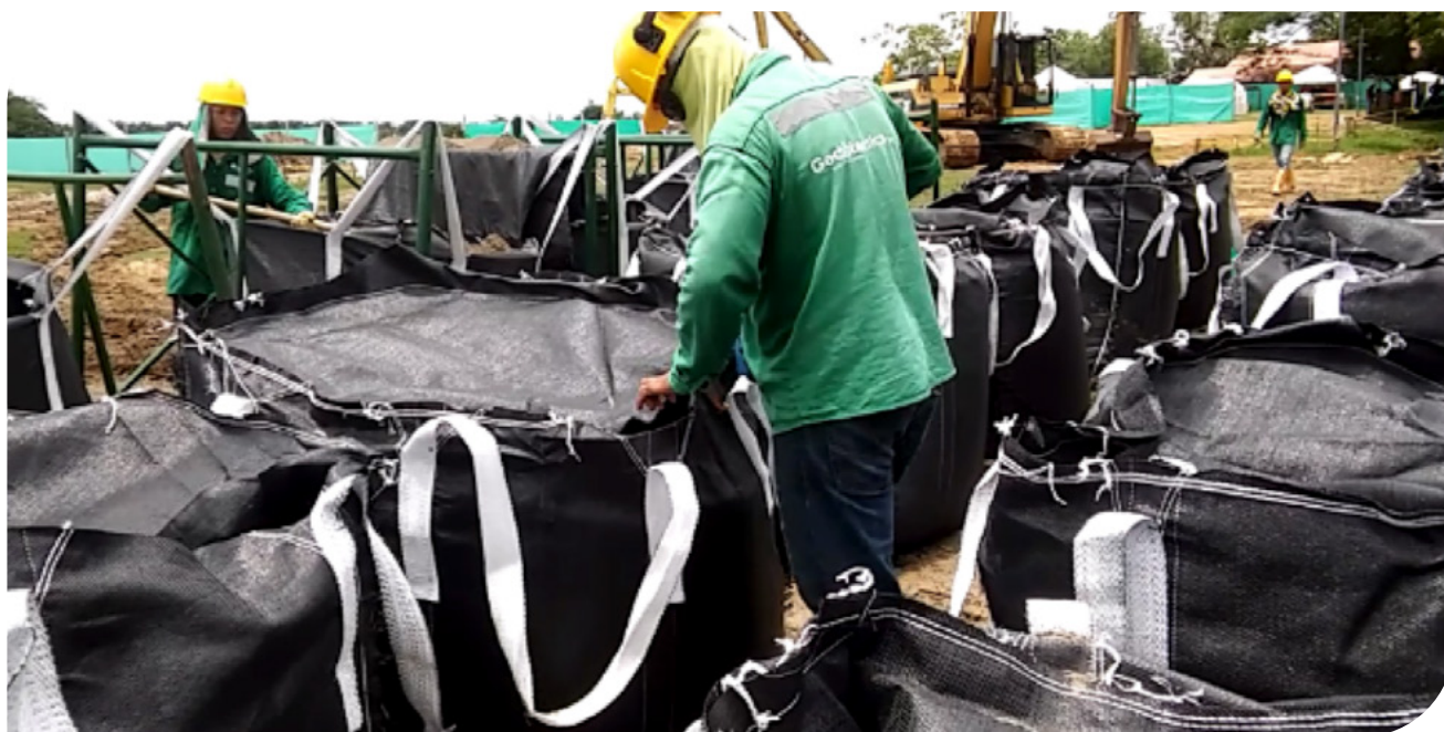
▲ Fotografia 17.8 | Sobreposição de coberturas no centro do preenchimento.
