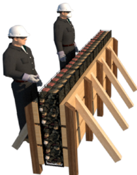
▲ Figura 17.16 | Uso de molde e preenchimento do Geocolchão.
