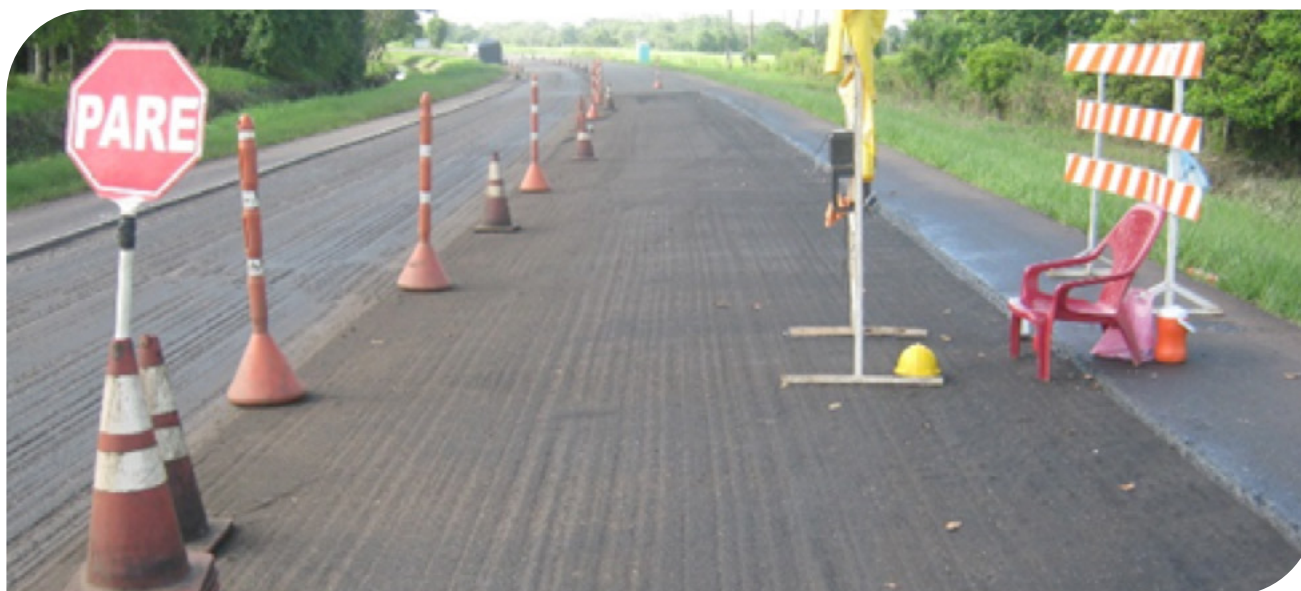
▲ Imagem 8.29 | Repavimentação. Superfície fresada com Geotêxtil Repav saturado. Concessão Autopista de los Llanos, Colômbia.
