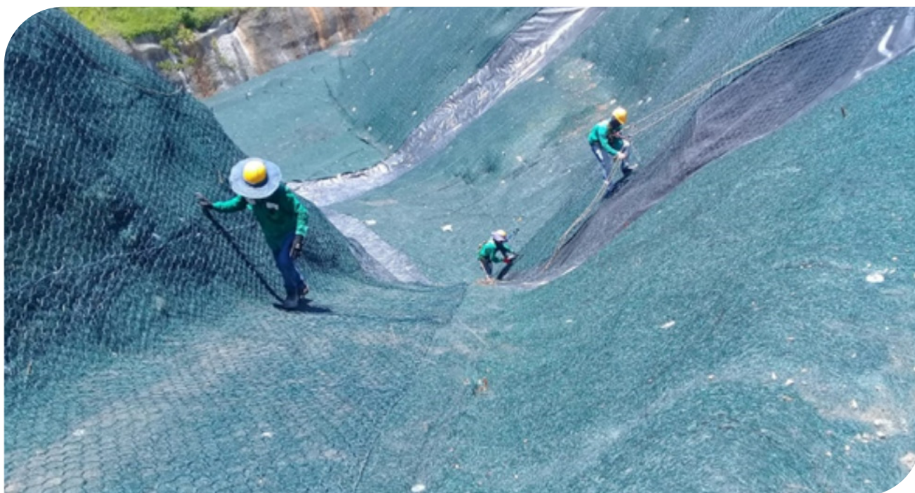
▲ Fotografia 16.3 | Manto Permanente em sistema G- Green.
