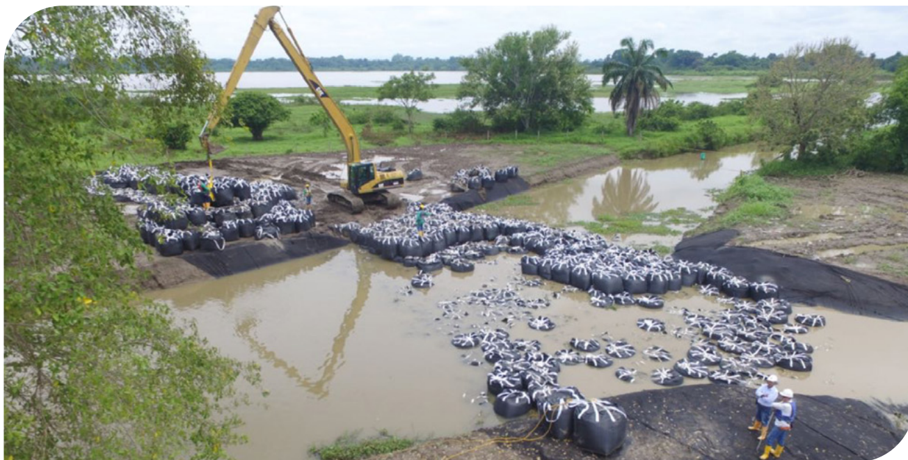
▲ Fotografia 17.56 | Construção de Dique mediante tecnologia Geoland em Pântano el Llanito Barrancabermeja - Santander Colômbia, construída pelo consórcio Obras San Silvestre.
