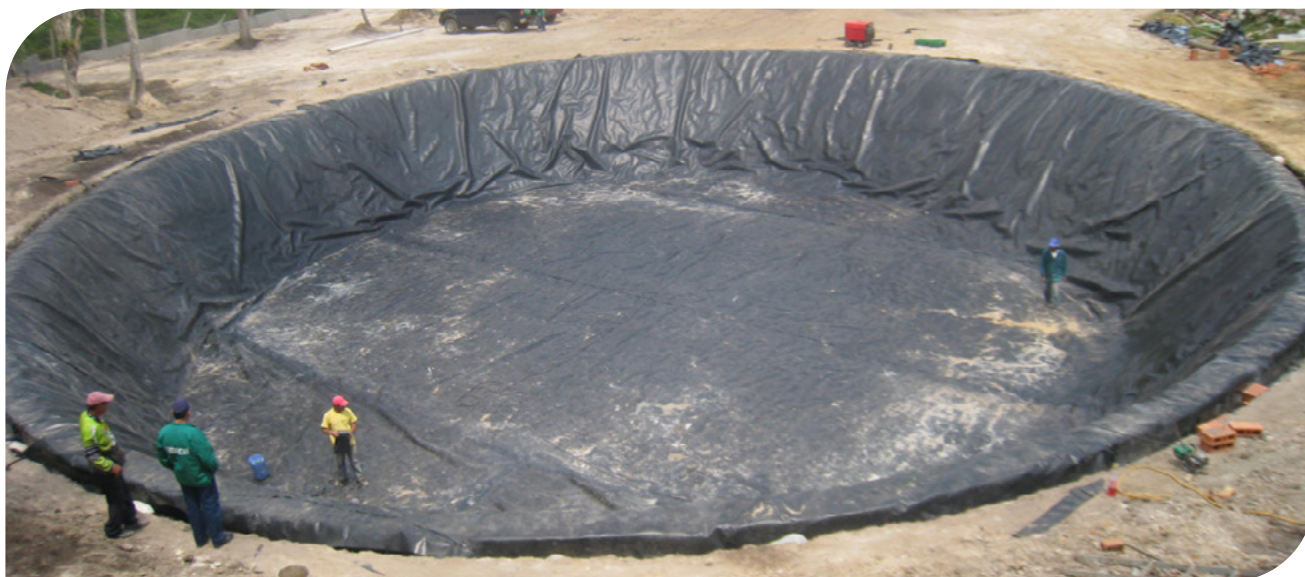
▲ Reservatório la Quinta del Puente | Santander 2011.
