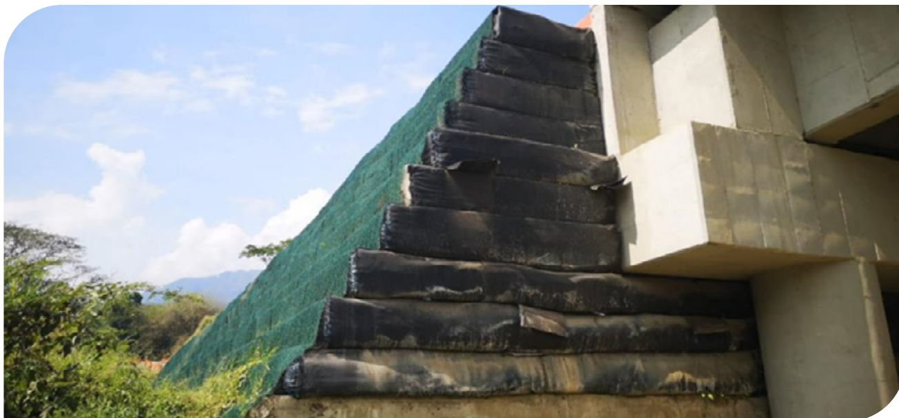
▲ Fotografia 11.11 | Fachada protegidas com Mantos Permanentes TRM.
