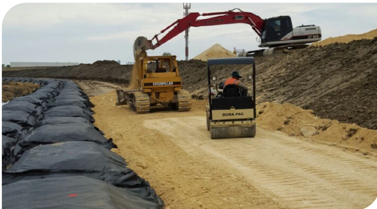
▲ Fotografia 17.15 | Formação de aterro na parte de trás da estrutura com Geobox.
