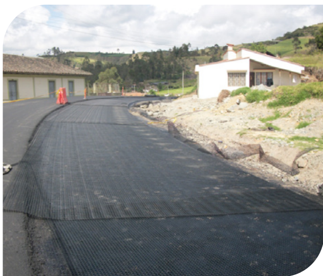
▲ Imagem 8.42 | Instalação de Geogrelha em curva em fase de recorte. Imagem 8.43 | Instalação de Geogrelha de Fibra de Vidro em curva terminada.
