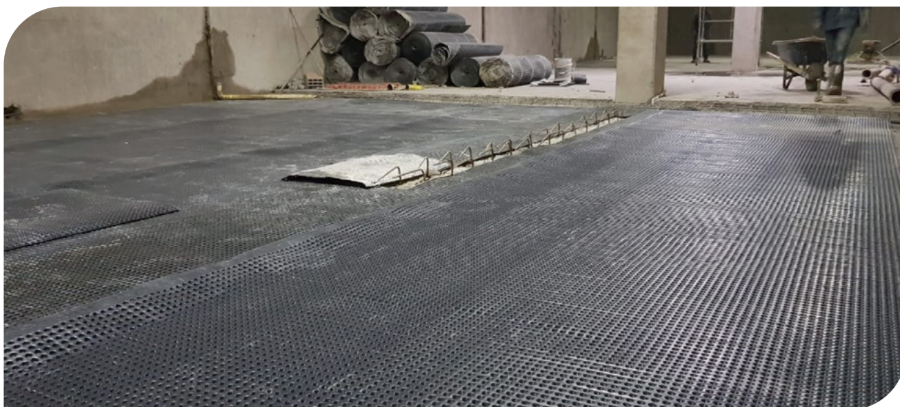
▲ Sistema de drenagem em fundações com ExtraDren | Edifício Sigma, Bogotá, Colômbia.
