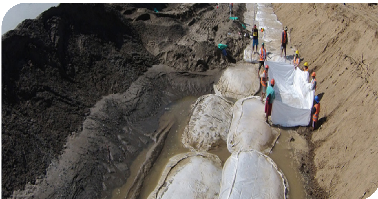
▲ Fotografia 17.14 | Instalação de Geobox de Geotêxtil TR6000.
