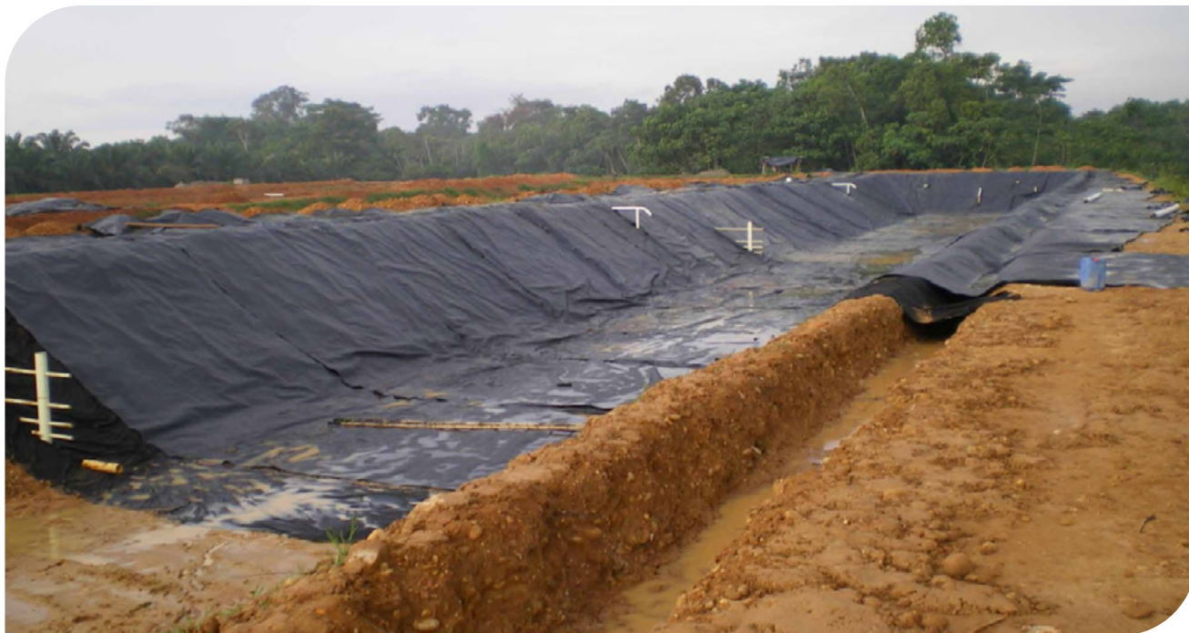
▲ Instalação de Geotêxtil Não Tecido para proteção de Geomembrana | Santander - 2009.
