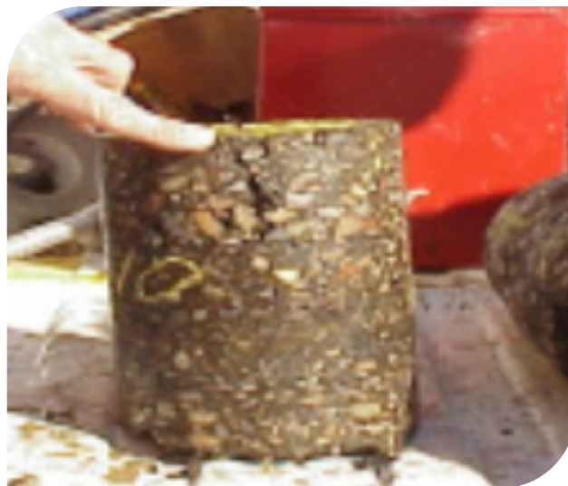
▲ Imagem 8.14 | Núcleo com "top-down cracking".
