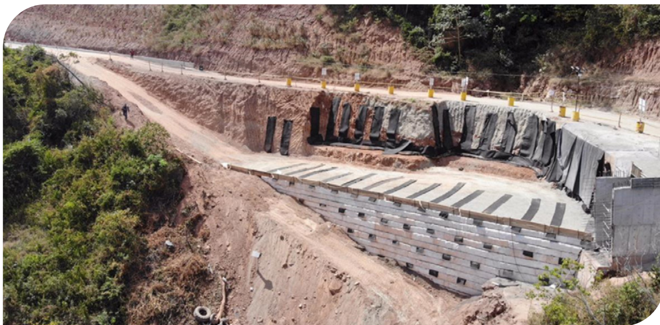
▲ Fotografia 11.8 | Instalação de drenos internos de Geocomposto Drenante Planar, muro em solo reforçado Gualanday
