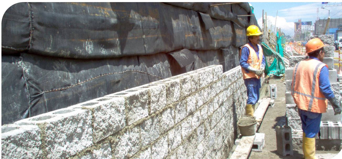
▲ Fotografia 11.9 | Fachada em painéis de concreto pré-moldado, como estrutura independente da parede em solo reforçado com Geotêxtil.
