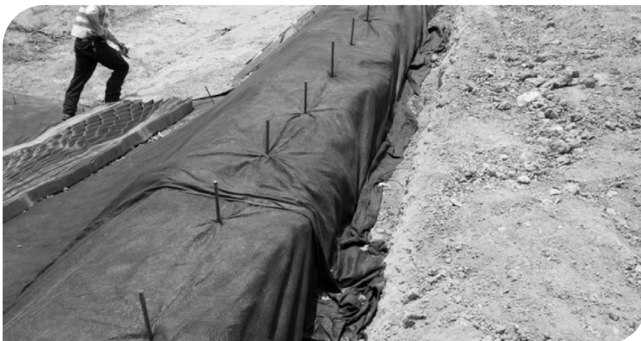
▲ Fotografia 17.51 | Ancoragens no ombro para extensão da Geocélula.
