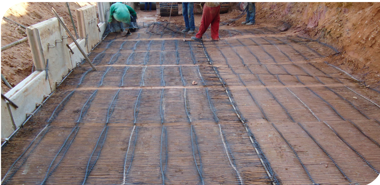
▲ Fotografia 11.10 | Fachada em painéis em escamas de concreto, como estrutura fixada à parede em solo reforçado com Geogrelha.
