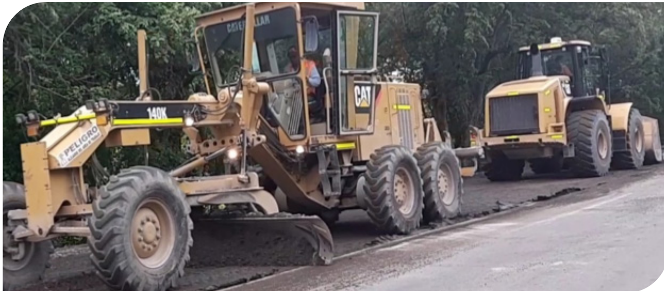
▲ Imagem 7.6 | Equipamentos para extensão e compactação. Autovía Neiva Girardot, Colômbia.
