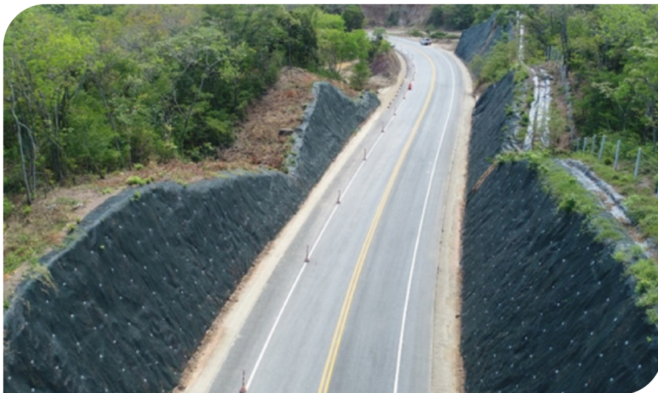
▲ Fotografia 16.6 | G-Green: Manto – Geogrelha Extrudada.
