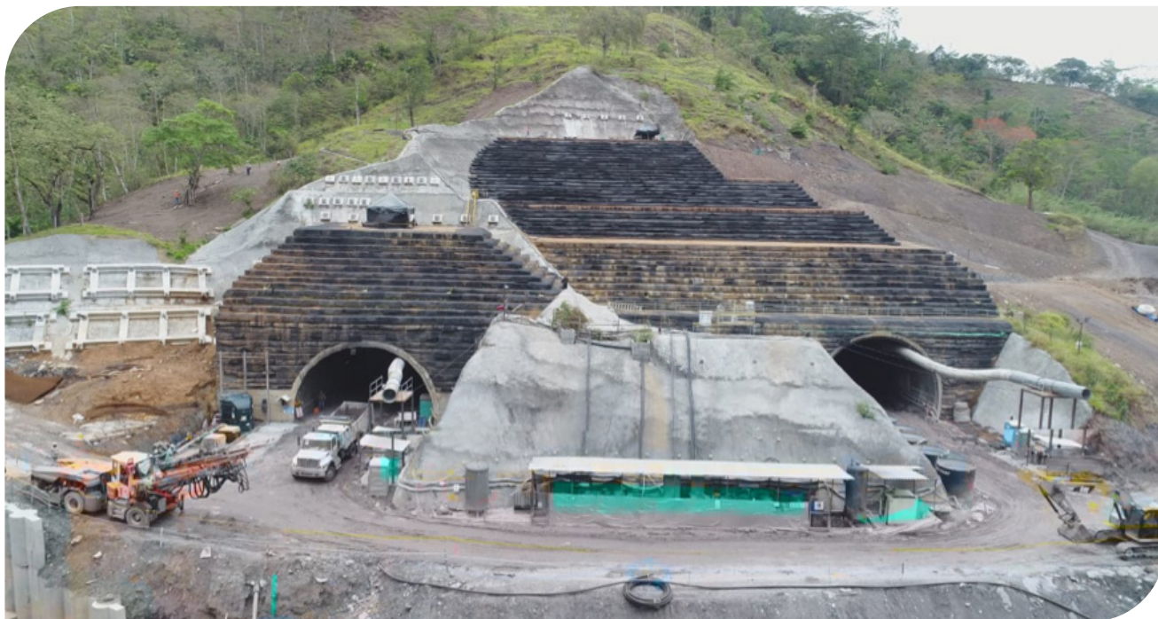
▲ Taludes reforçados | Portal Túnel 8 Estrada do Sol 1.
