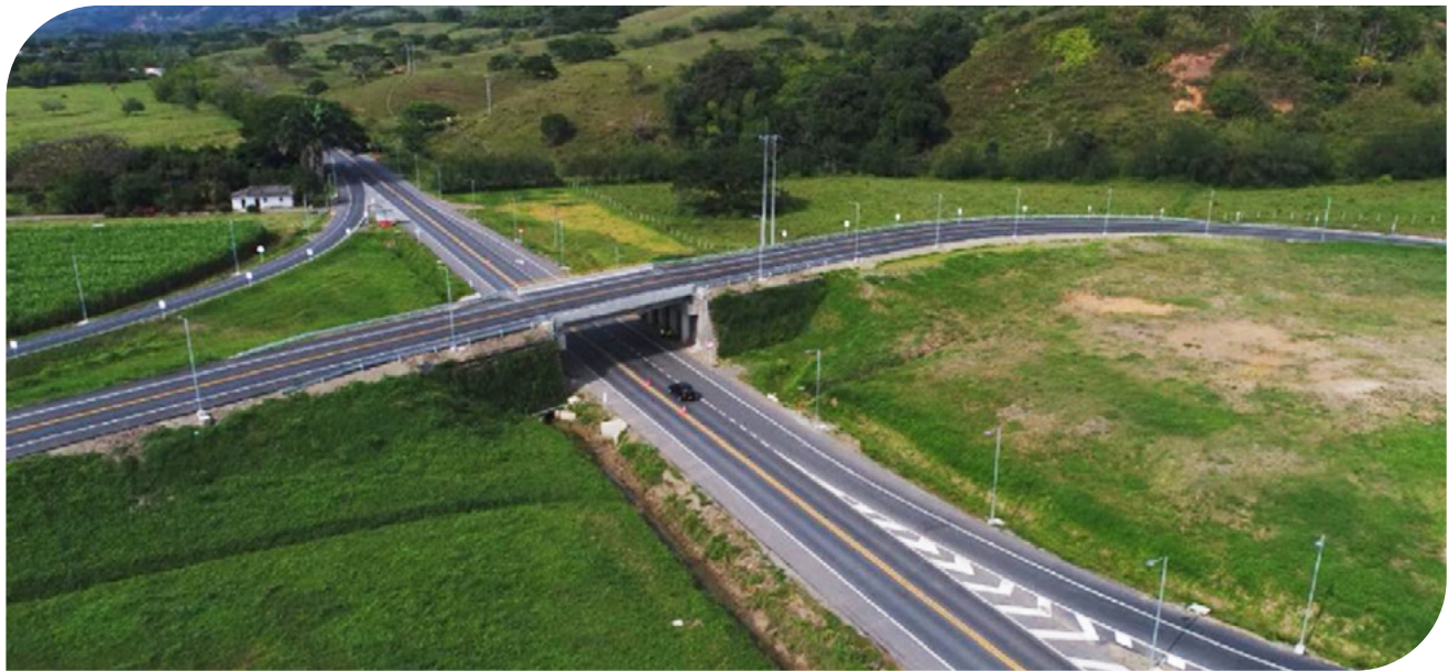
▲ Fotografia 11.15 | Muro em Solo reforçado Projetado e construído sob Metodologia WSD.
