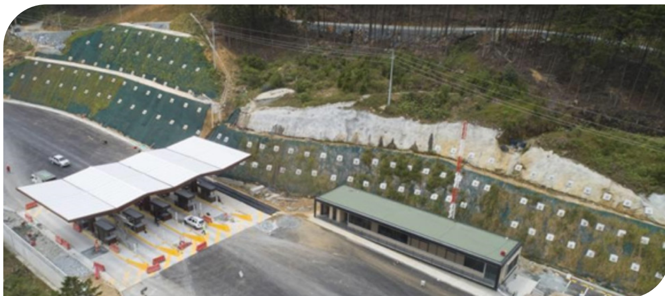
▲ Fotografia 16.10 | G-Green: Manto, malha talude, solo grampeado. Túnel oriental.
