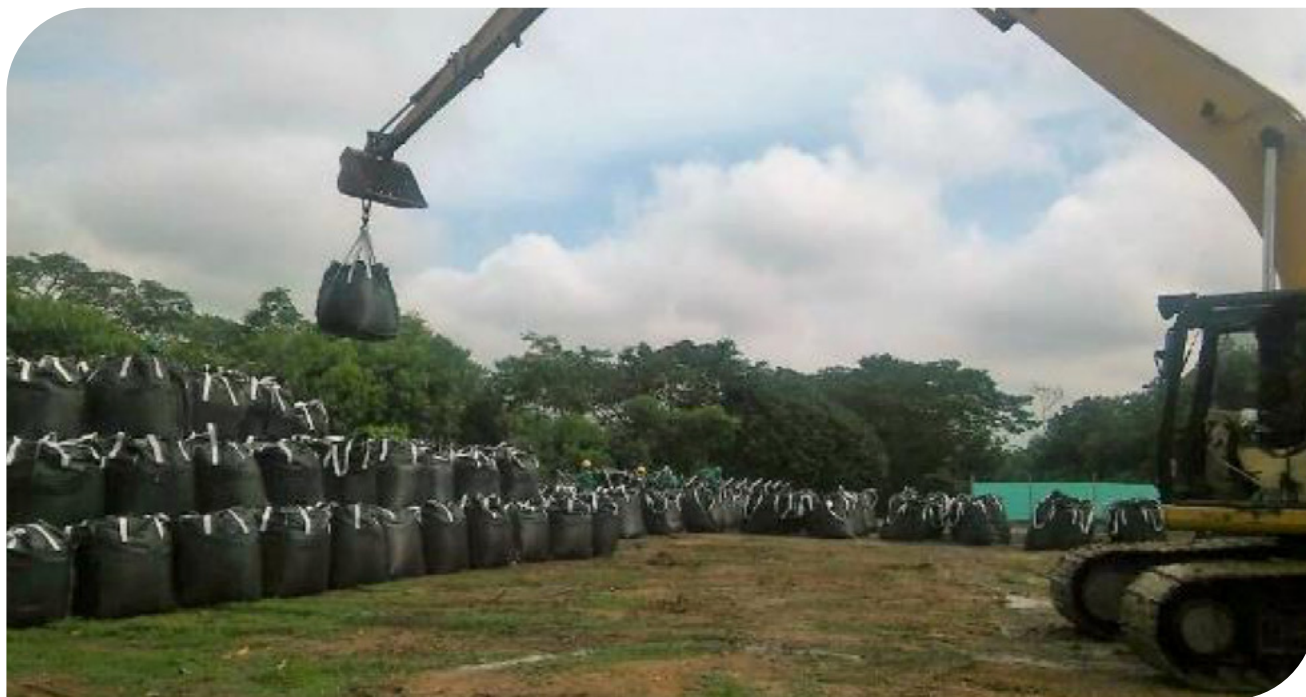
▲ Fotografia 17.9 | Armazenamento de Geobags.
