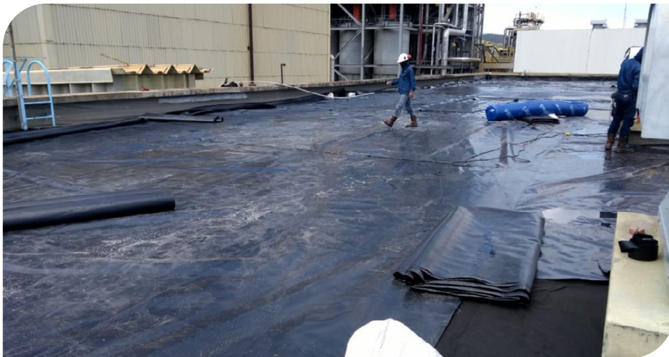
▲ Impermeabilização de telhados | Norte de Santander - 2018.
