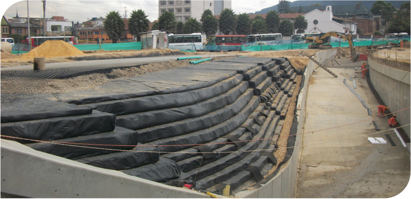
▲ Taludes reforçados | Conselho de Bogotá.
