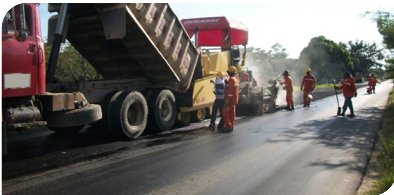
▲ Imagem 8.44 | Repavimentação com Geogrelha de Fibra de Vidro. Processo contínuo e simultâneo.
