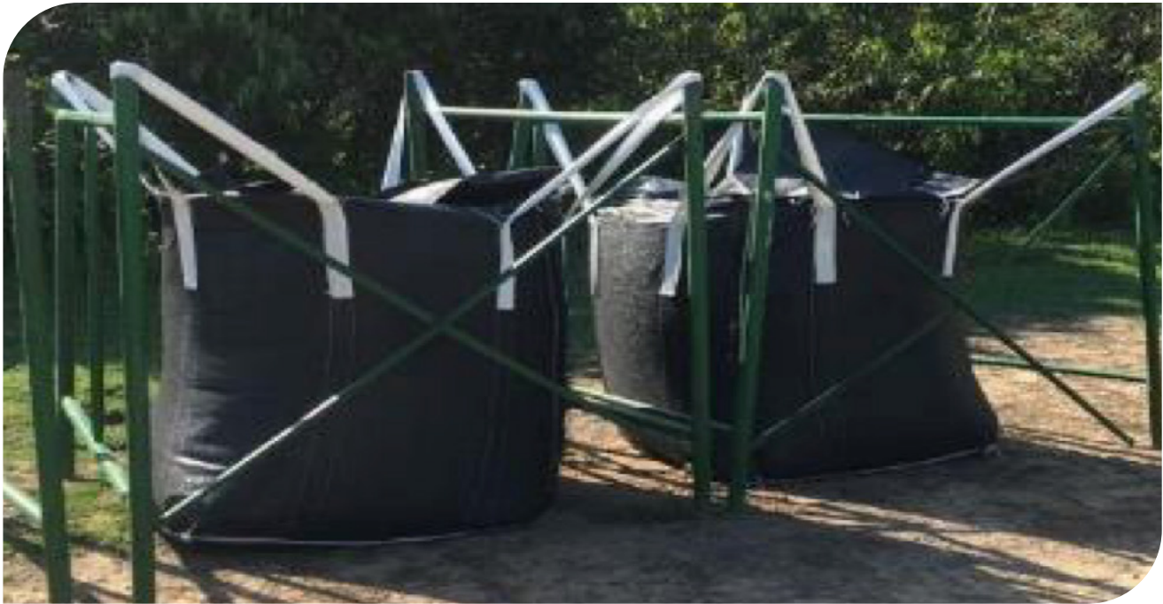
▲ Fotografia 17.5 | Sustentação de Geobags com Andaimos.
