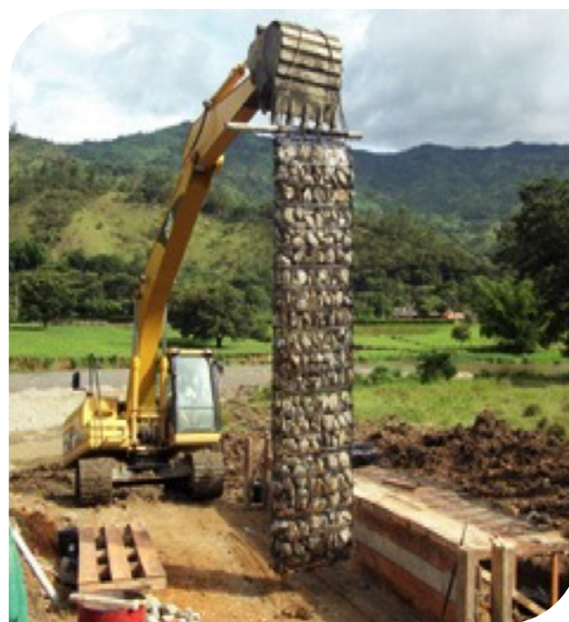
▲ Fotografia 17.28 | Geocolchões içados.
