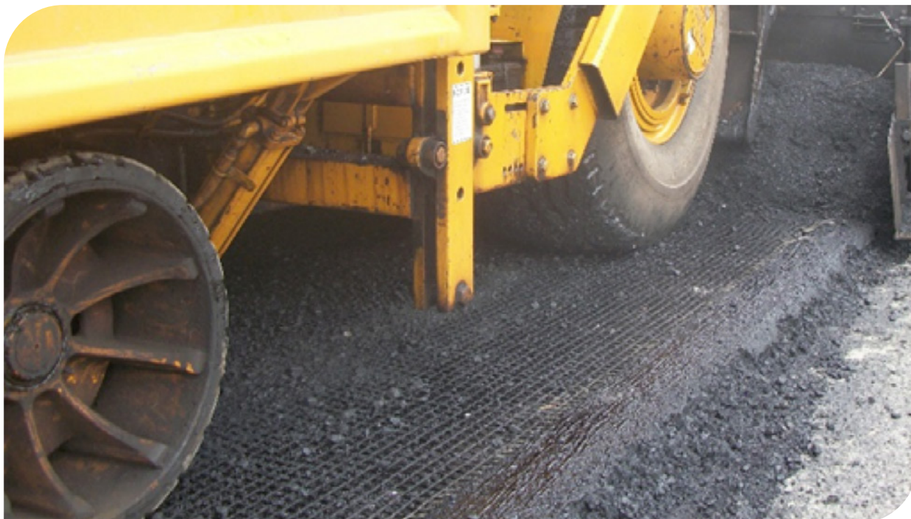
▲ Imagem 8.37 | Repavimentação com Geogrelha de Fibra de Vidro. Nariño, Colômbia.
