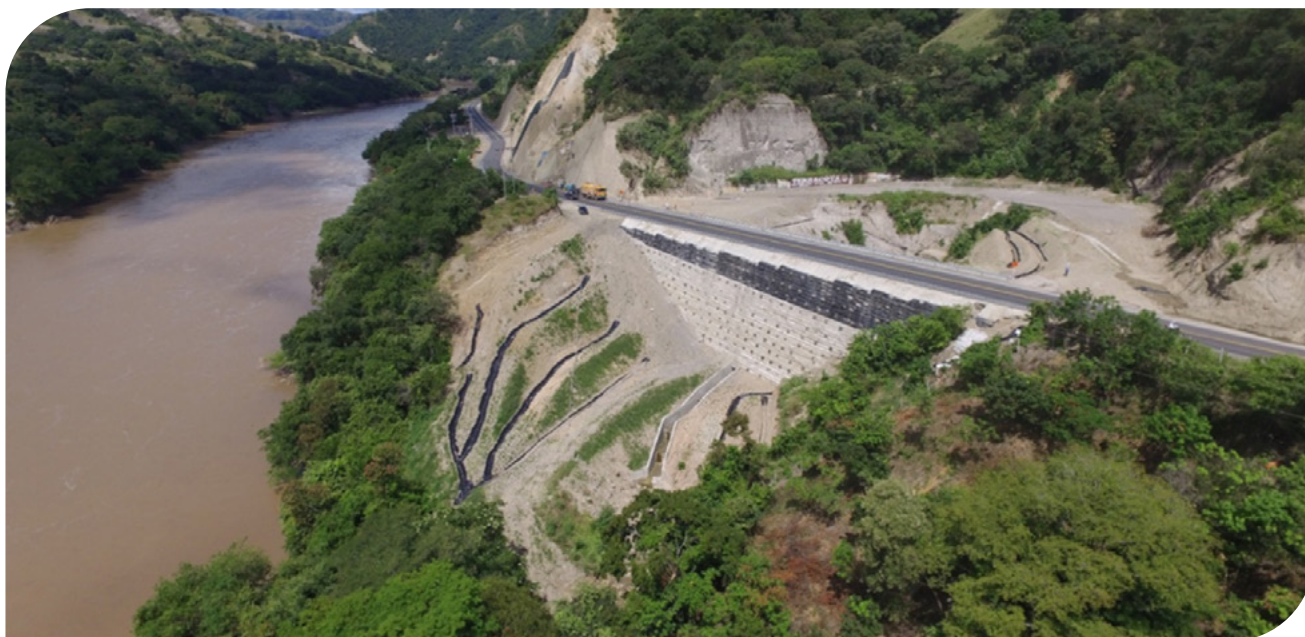
▲ Fotografia 11.1 | Muro em solo reforçado, Concessão ALMA, Honda-Tolima-Colombia.
