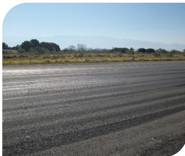
▲ Imagem 8.4 | Formação de afundamentos.
