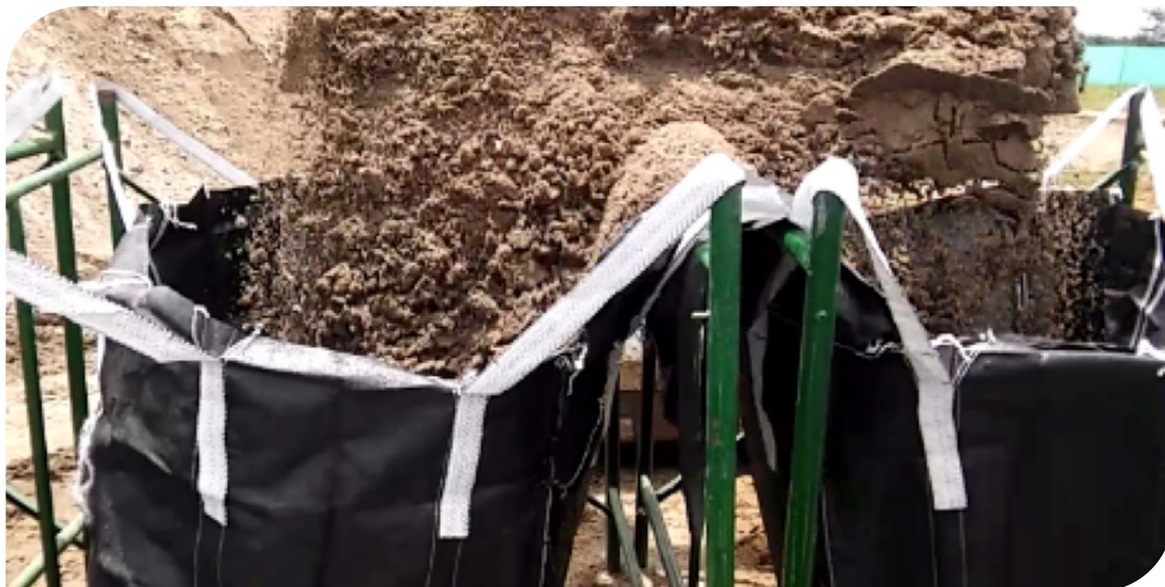
▲ Fotografia 17.7 | Sobreposição de coberturas no centro do preenchimento.
