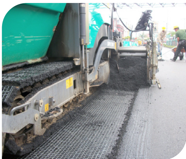
▲ Imagem 8.17 | Repavimentações com Geogrelha de Fibra de Vidro, Estrada 14 Armenia.
