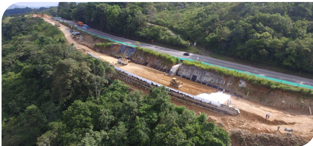
▲ Fotografia 11.6 | Projeto e construção de muro em solo reforçado, APP GICA, Ibagué – Tolima, seção crítica H:11.7m, K2+406.
