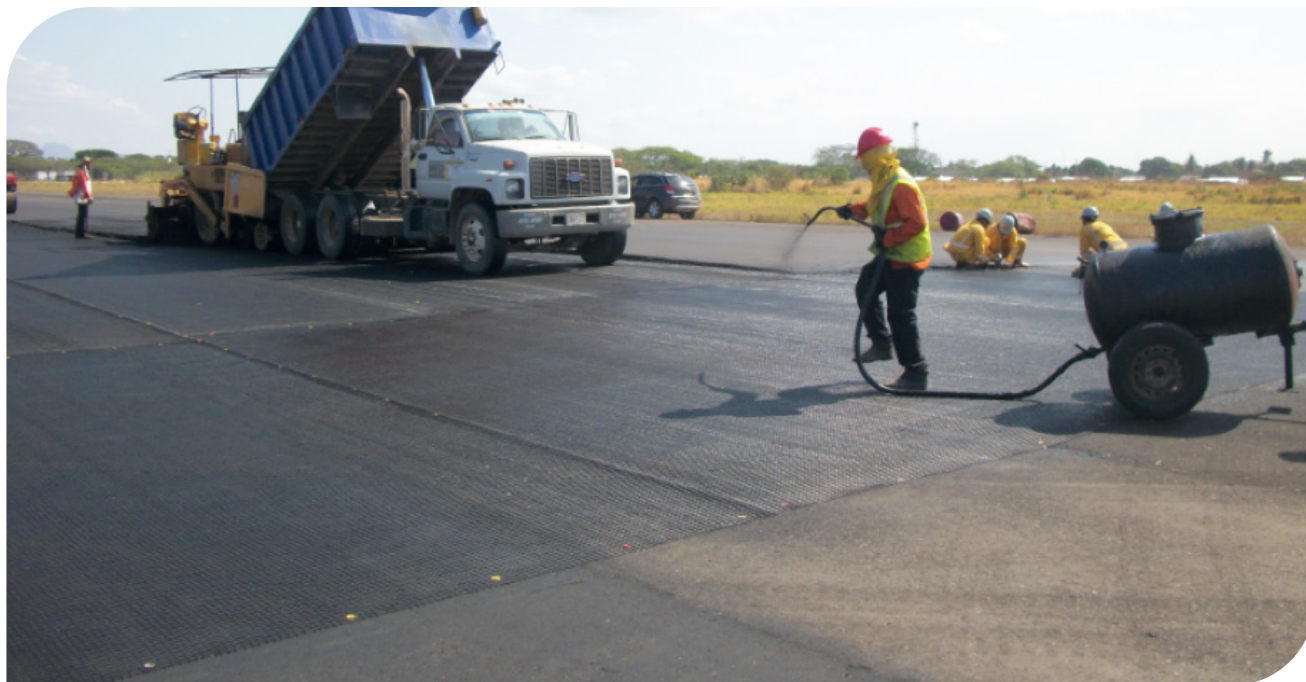
▲ Imagem 8.39 | Emulsão asfáltica com equipamento aspersor.
