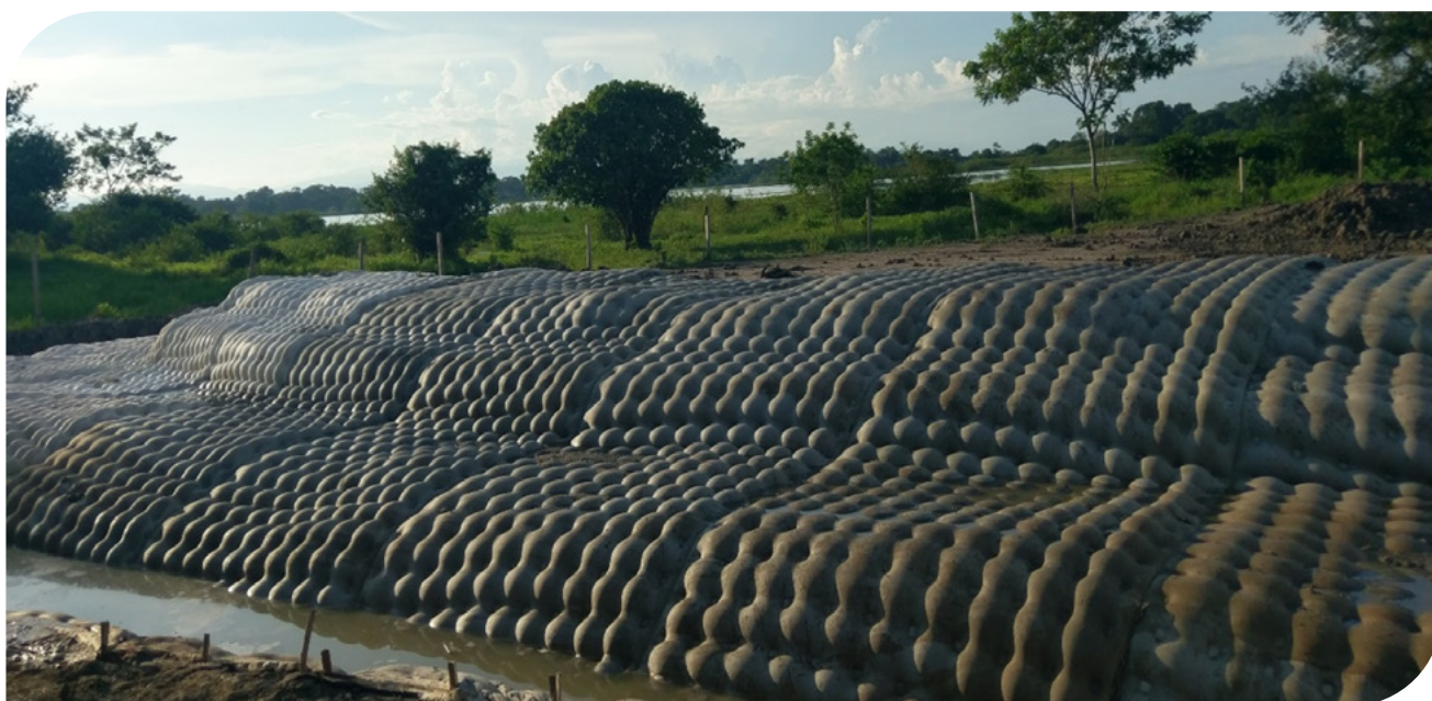
▲ Fotografia 17.61 | Revestimento com Flexocreto 10000 em Caño Cocos Pântano el Llanito Barrancabermeja Santander – Colômbia.
