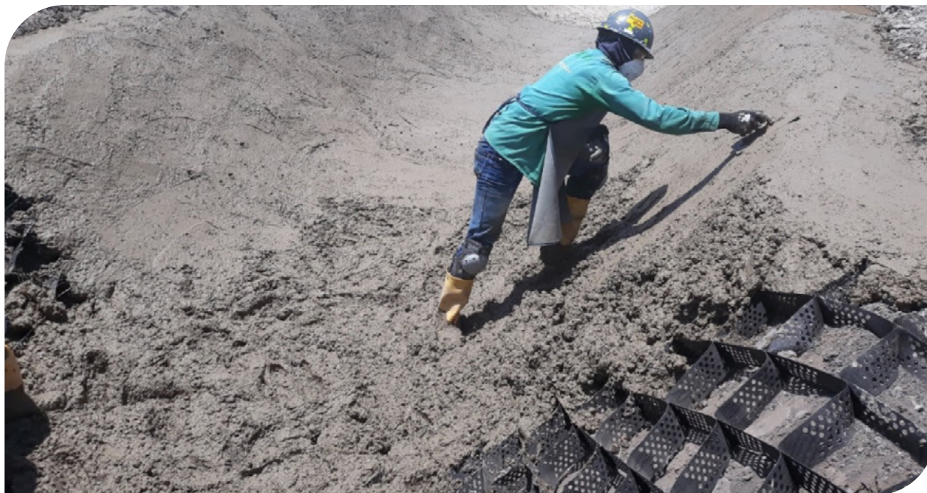
▲ Fotografia 17.52 | Preenchimento com material de Concreto.
