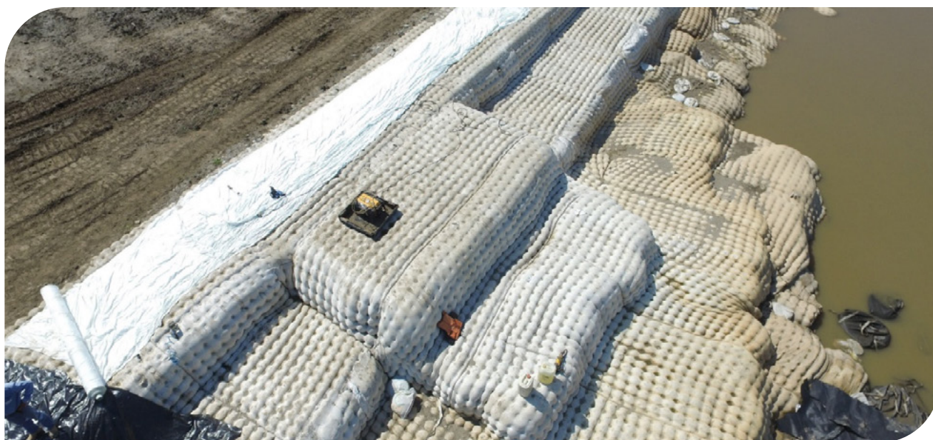
▲ Fotografia 17.4 | Proteção superficial com Flexocreto.
