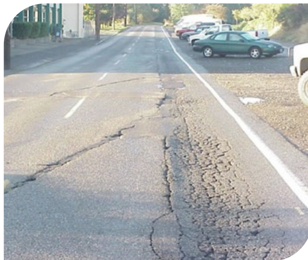
Imagem 8.2 | Couro de jacaré acompanhada de formação de afundamentos (der.)Alta gravidade. 1
