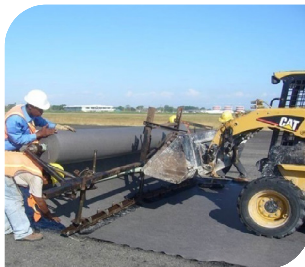
▲ Imagem 8.35 | Instalação mecânica dos rolos do Geotêxtil de Repavimentação.
