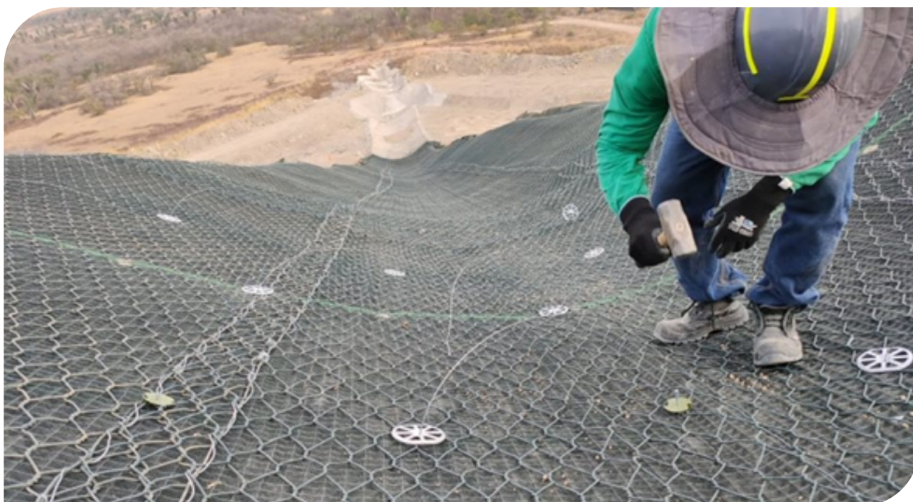
▲ Fotografia 16.5 | Malha de talude em sistema G-Green.
