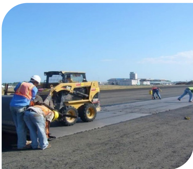
▲ Imagem 8.35 | Instalação mecânica dos rolos do Geotêxtil de Repavimentação.
