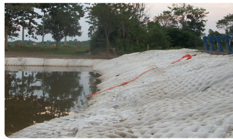
▲ Proteção de estruturas hidráulicas
