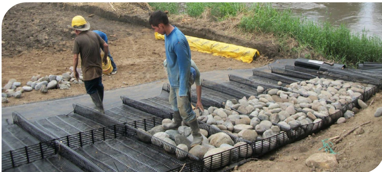
▲ Fotografia 17.31 | Preenchimento do Geocolchão com pedregulho.
