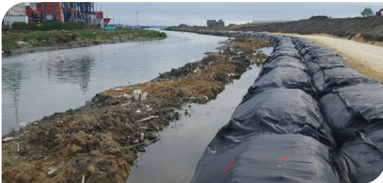
▲ Fotografia 17.10 | Barreiras de proteção com Geobox.
