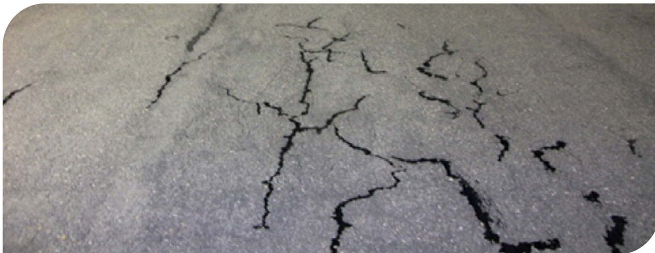
▲ Imagem 8.31 | Vedação de trincas. Aeropista, Colômbia.
