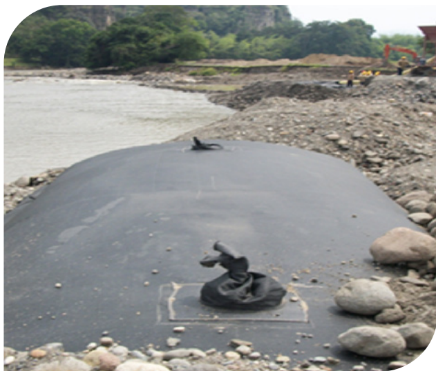
▲ Fotografia 17.19 | Detalhe do fechamento do mangote. ▲ Fotografia 17.20 | Modo de costura.
