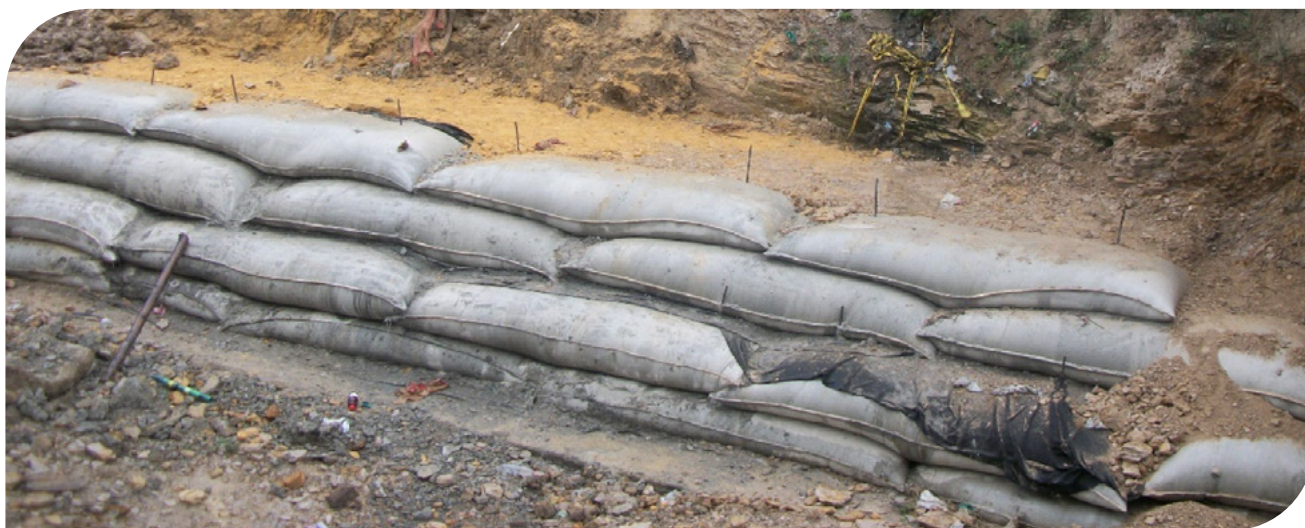
▲ Fotografia 17.36 | Articulação das Durabags com varas de aço.
