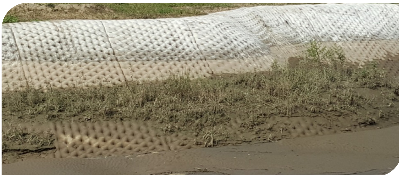
▲ Fotografia 17.43 | Algas e vegetação crescendo sobre o Flexocreto.
