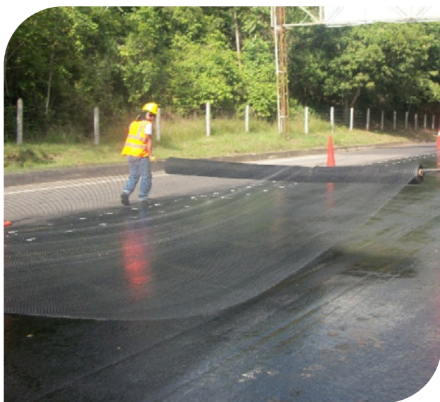
▲ Imagem 8.40 | Instalação manual dos rolos da Geogrelha de Fibra de Vidro.
