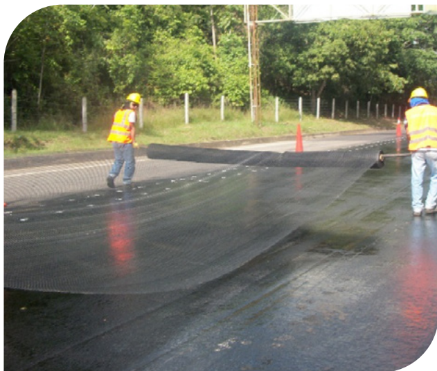
▲ Imagen 8.40 | Instalación manual de los rollos de Geomalla de Fibra de Vidrio.
