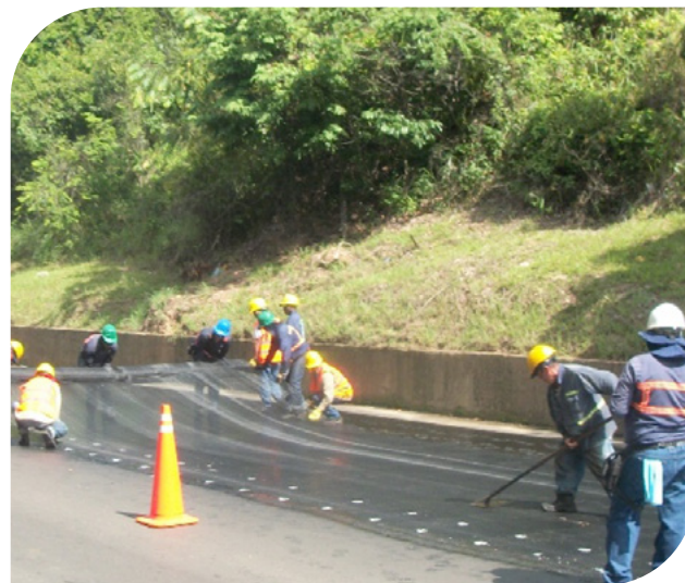
▲ Imagen 8.40 | Instalación manual de los rollos de Geomalla de Fibra de Vidrio.
