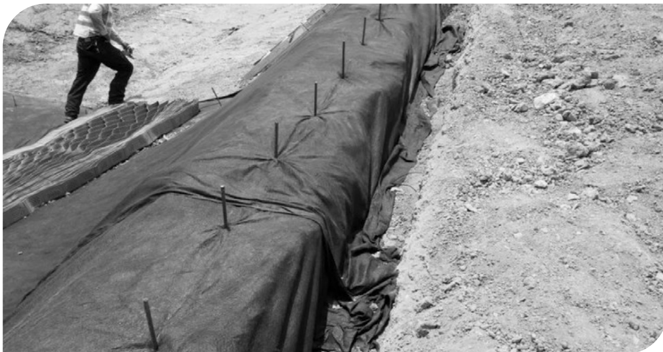
▲ Fotografía 17.51 | Anclajes en el hombro para extensión de la Geocelda.
