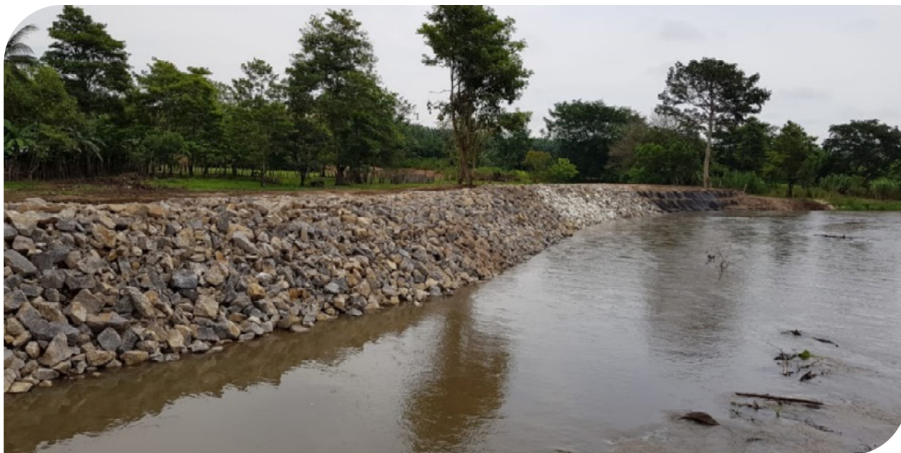
▲ Fotografía 17.17 | Fachada con bloques de roca en solución con Geobox.
