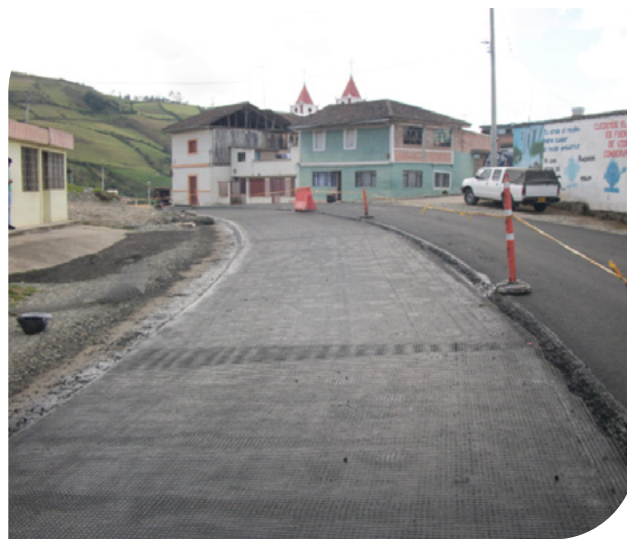
Imagen 8.43 | Instalación de Geomalla de Fibra de Vidrio en curva terminada.
