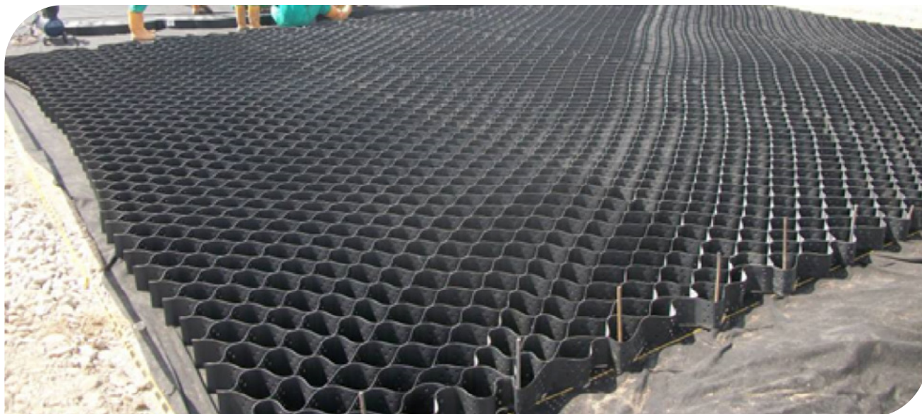
▲ Imágen 7.2. | Varillas de soporte para la instalación de la Geocelda.
