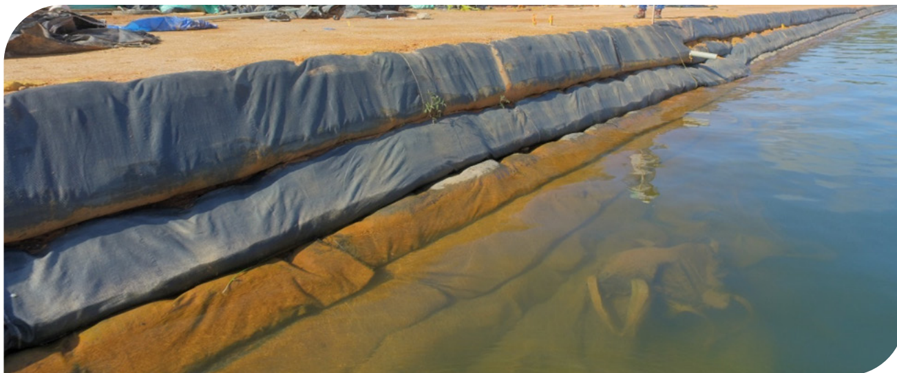
▲ Fotografía 17.57 | Conformación de cuerpo sobre estructura de cimentación en sistema Geoland Malecón turístico Guatapé.
