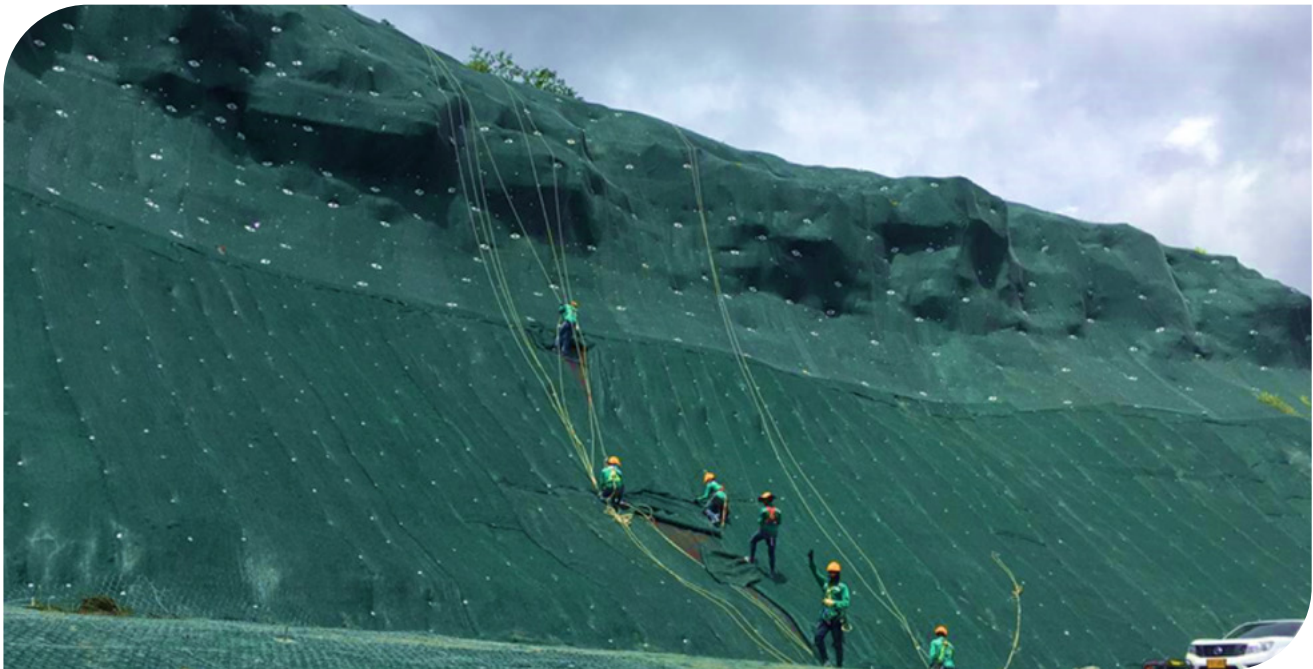
▲ Fotografía 16.7 | G-Green: Manto – malla talud. CES - ISAGEN.
