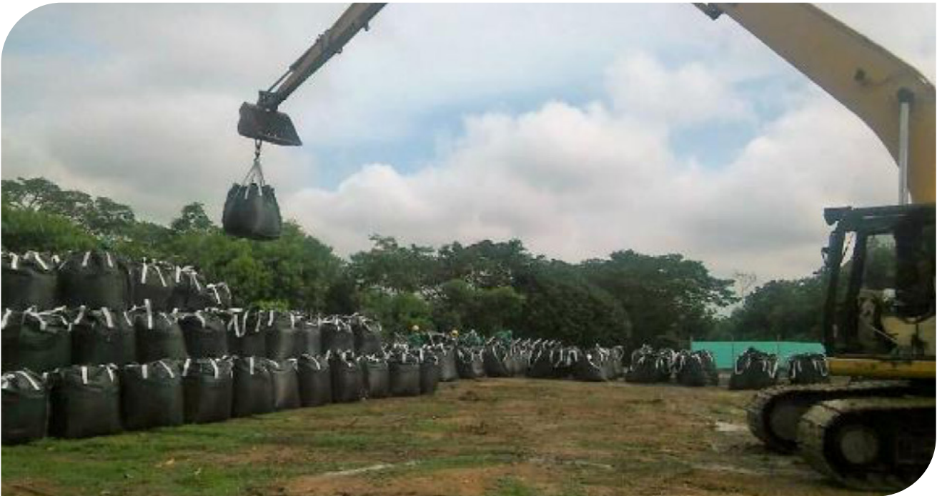
▲ Fotografía 17.9 | Almacenamiento de Geobags.
