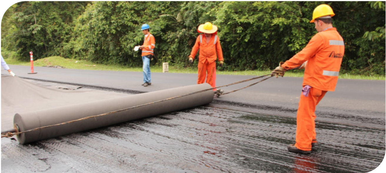
▲ Repavimentación con Geotextil No Tejido REPAV | Autopistas de los Llanos, Villavicencio, Colombia.
