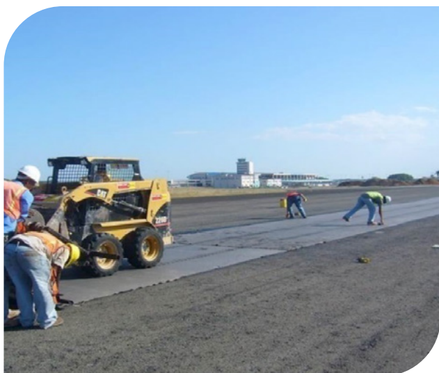
▲ Imagen 8.35 | Instalación mecánica de los rollos de Geotextil de Repavimentación. Imagen 8.36 | Detalle de instalación con adaptación del minicargador.
