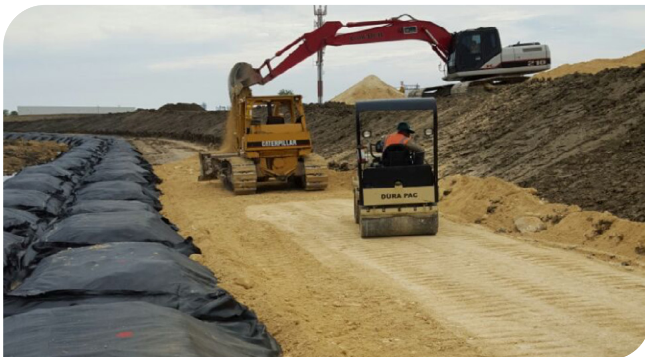
▲ Fotografía 17.15 | Conformación de relleno en el trasdós de estructura con Geobox.
