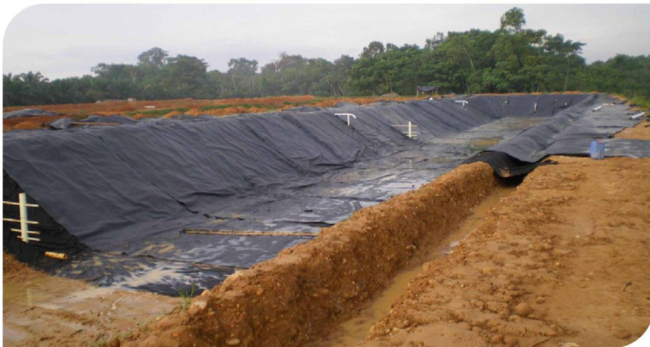
▲ Instalación Geotextil No Tejido para protección de Geomembrana | Santander - 2009.
