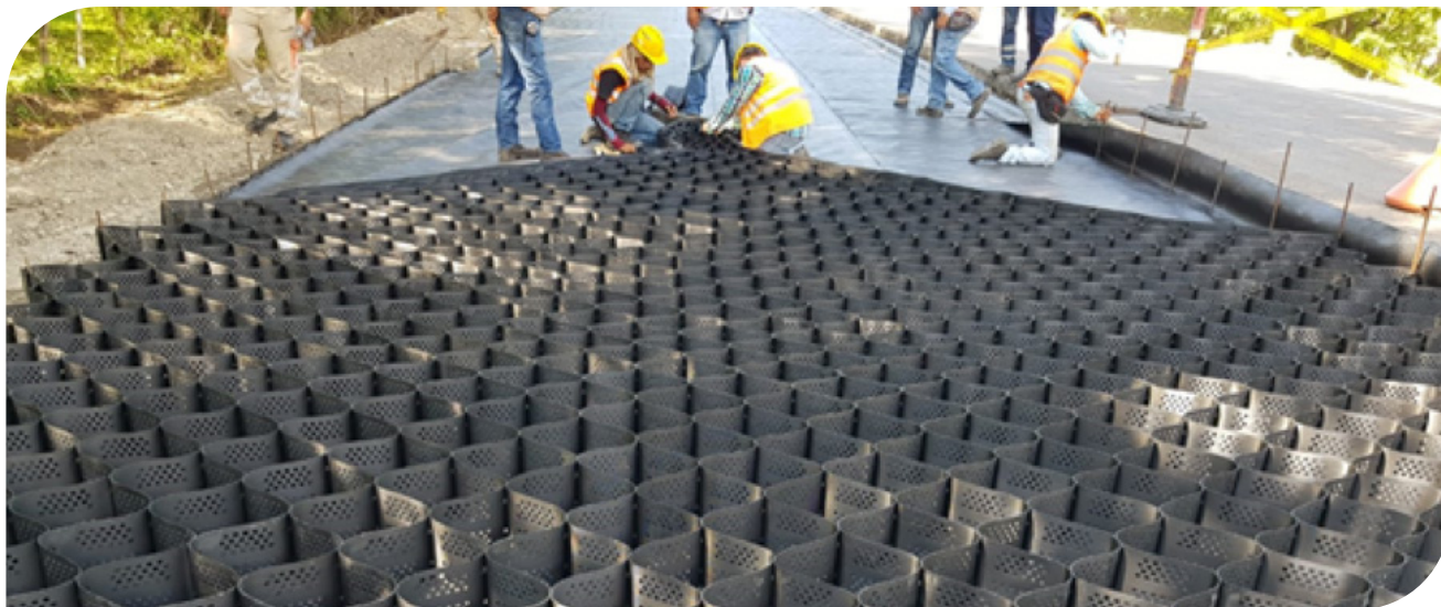
▲ Imágen 7.4 | Extensión Geocelda de confinamiento Celular. Autovía Neiva Girardot, Colombia.
