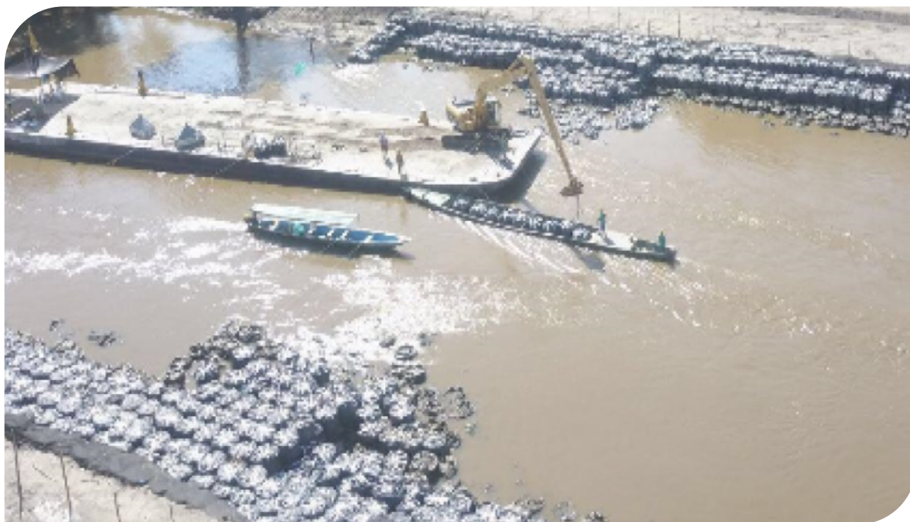
▲ Fotografía 17.1 | Estructura de control Caño San Silvestre con bolsas de Geotextil Tejido.
