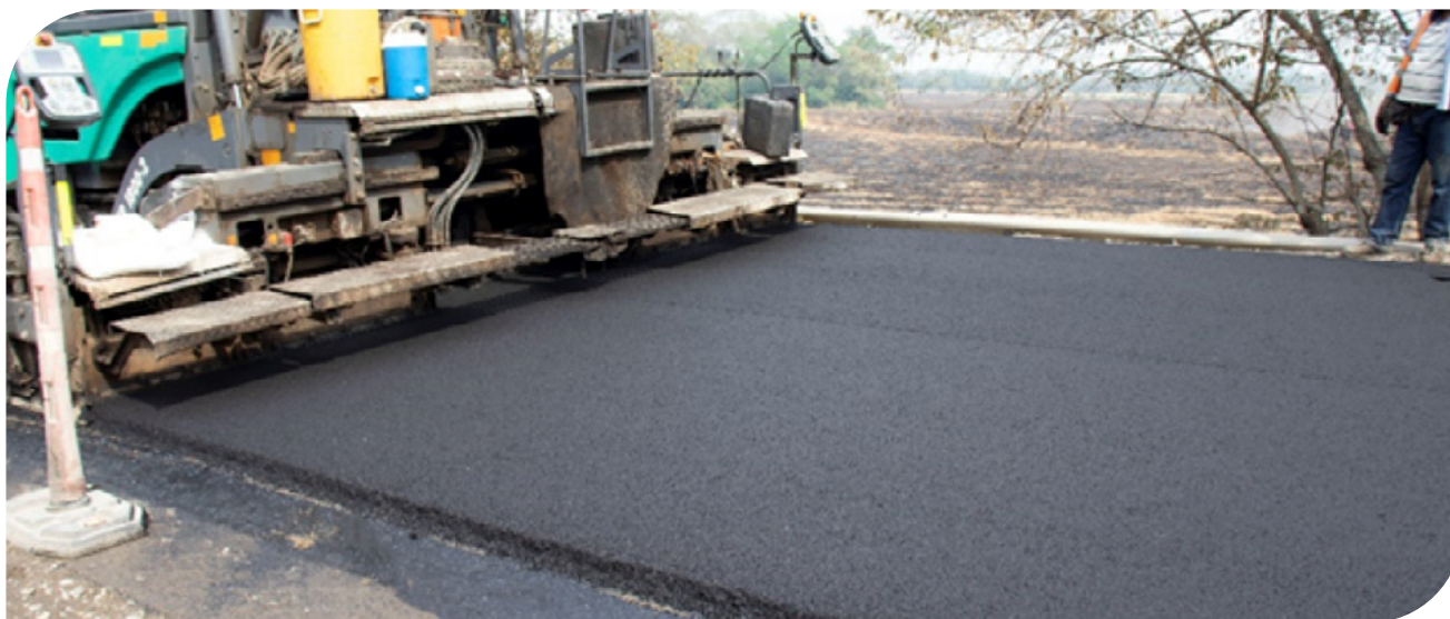
▲ Imágen 7.7 | Extensión Concreto Asfáltico. Autovía Neiva Girardot, Colombia.
