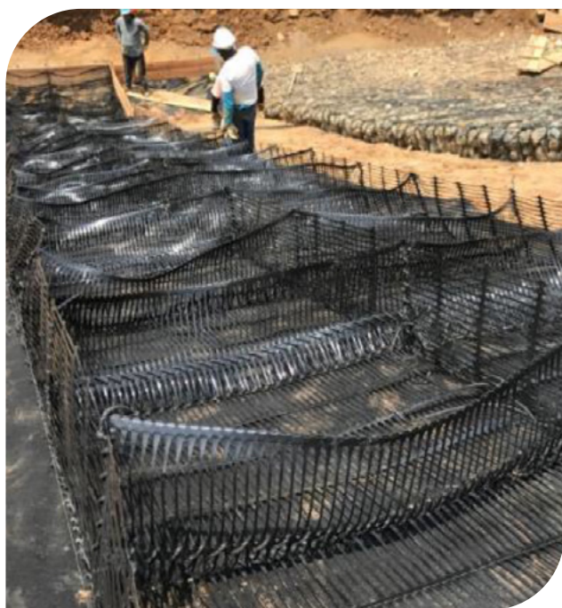
▲ Fotografía 17.27 | Geocolchones armado in-situ.
