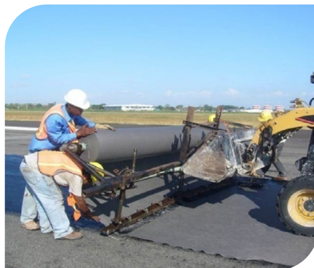
▲ Imagen 8.35 | Instalación mecánica de los rollos de Geotextil de Repavimentación. Imagen 8.36 | Detalle de instalación con adaptación del minicargador.
