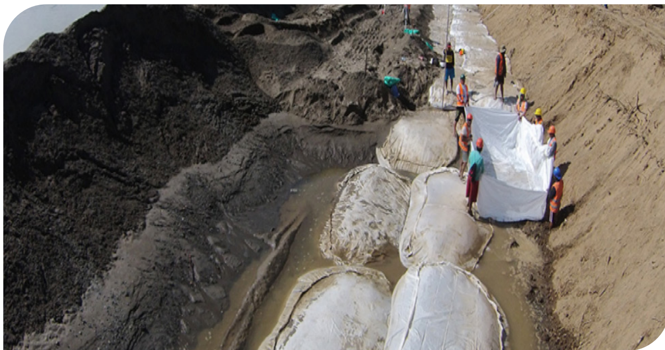
▲ Fotografía 17.14 | Instalación de Geobox de Geotextil TR6000 HF.
