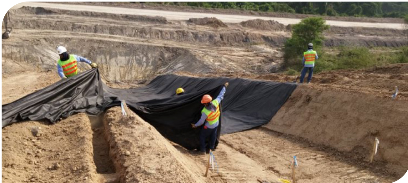
▲ Fotografía 17.46 | Conformación Zanja de Anclaje.
