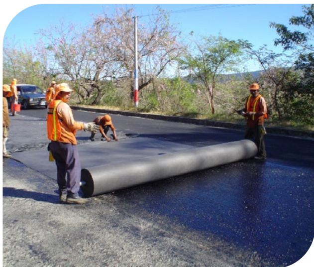
▲ Imagen 8.33 | Instalación manual de los rollos de Geotextil de Repavimentación. ▲ Imagen 8.34 | Paso de irrigador sobre el Geotextil para segundo riego.
