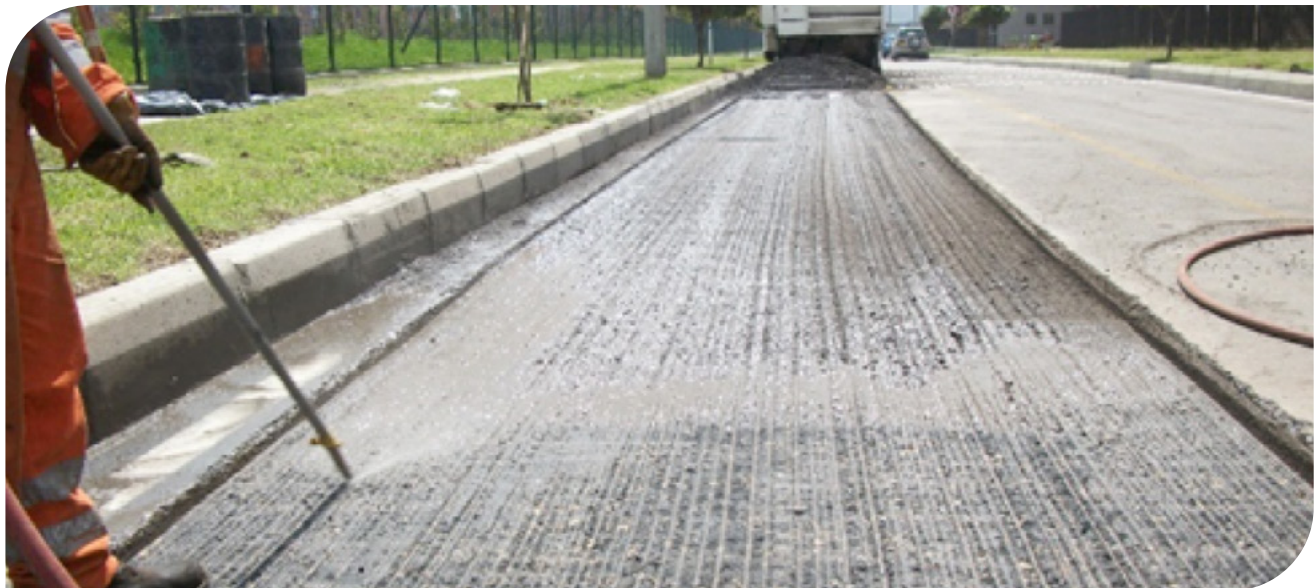
▲ Imagen 8.30 | Soplado con compresor de superficie fresada. Ciudad Verde, Soacha, Colombia.
