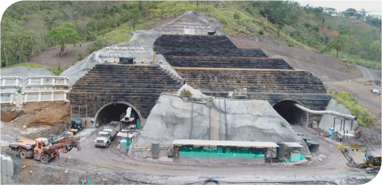
▲ Terraplenes Reforzados | Portal Túnel 8 Ruta del Sol 1.
