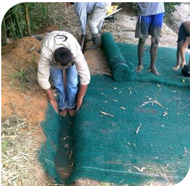
▲ Fotografías 17.21 - 17.22 | Geotextile Tubes protegidos con manto para control de erosión.
