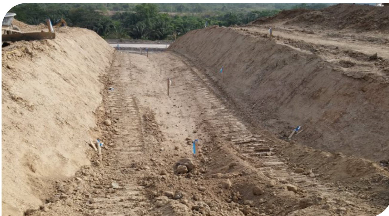
▲ Fotografía 17.45 | Preparación del terreno natural.
