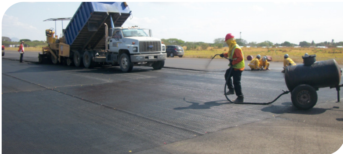
▲ Imagen 8.39 | Riego de emulsión con equipo aspersor.
