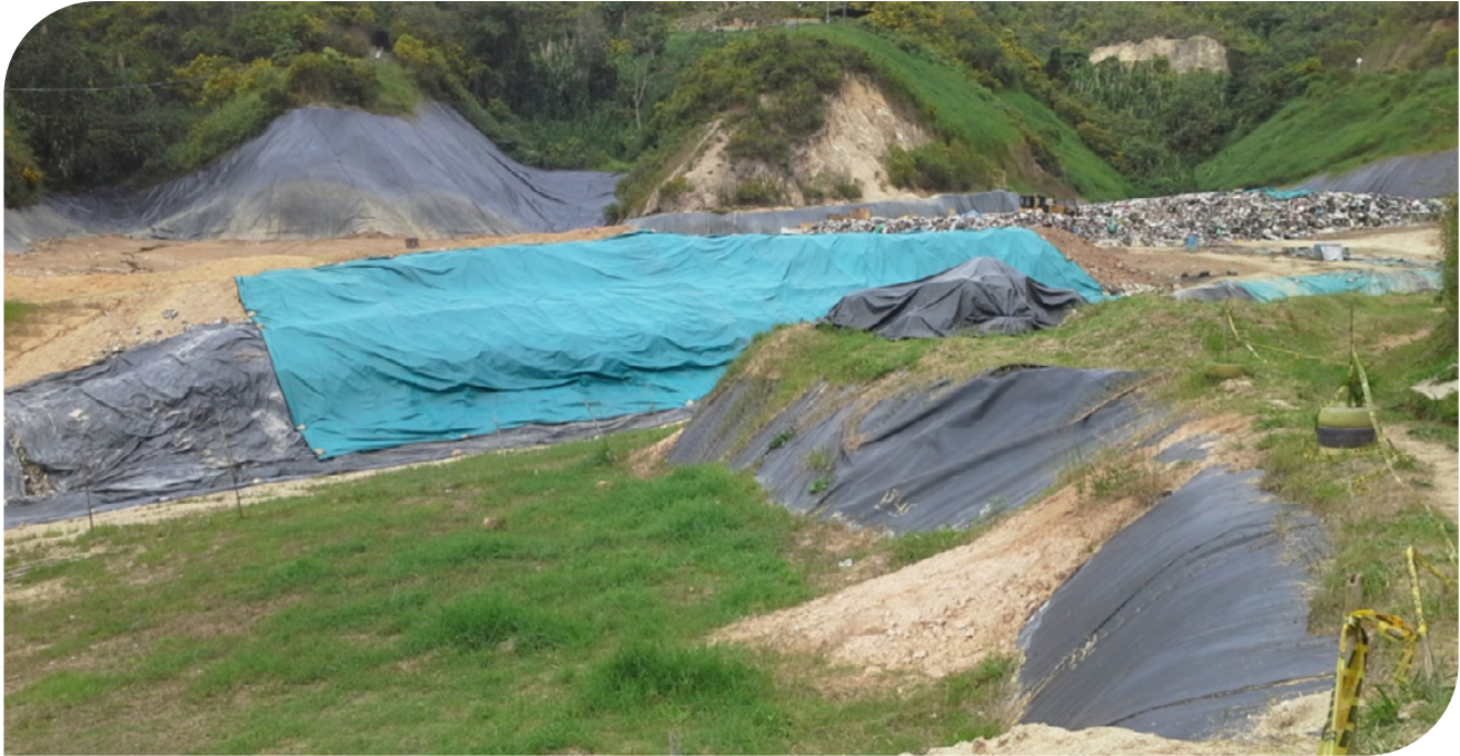
▲ Relleno Sanitario Ocaña | Norte de Santander 2018.
