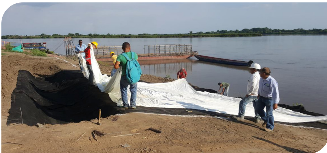
▲ Fotografía 17.41 | Instalación del Flexocreto, proyecto Tamalameque, departamento de Cesar, Colombia.
