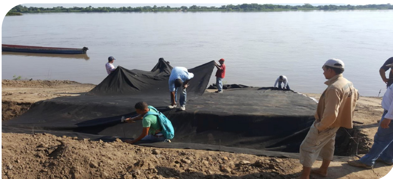
▲ Fotografía 17.39 | Colocación de Geotextil no tejido proyecto Tamalameque, departamento de Cesar, Colombia.
