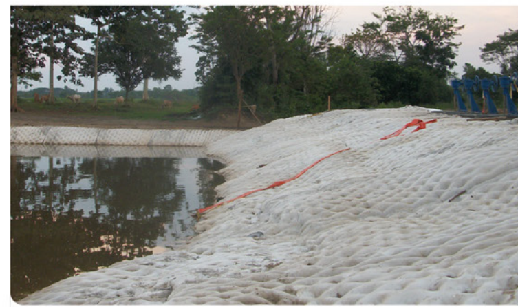
▲ Protección de estructuras hidráulicas.
