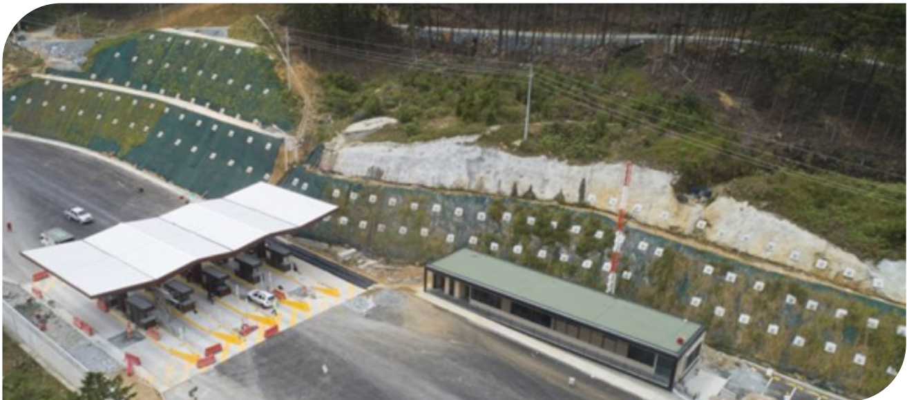
▲ Fotografía 16.10 | G-Green: Manto, malla talud, soil nailing. Túnel de oriente.
