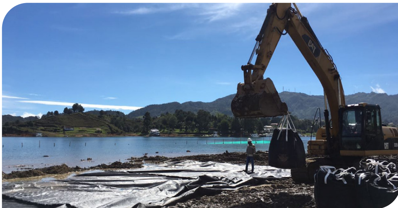
▲ Fotografía 17.59 | Instalación de Geotextil de refuerzo en el malecón turístico de Guatapé Antioquia Colombia, construido por la Unión Temporal obras Guatapé.
