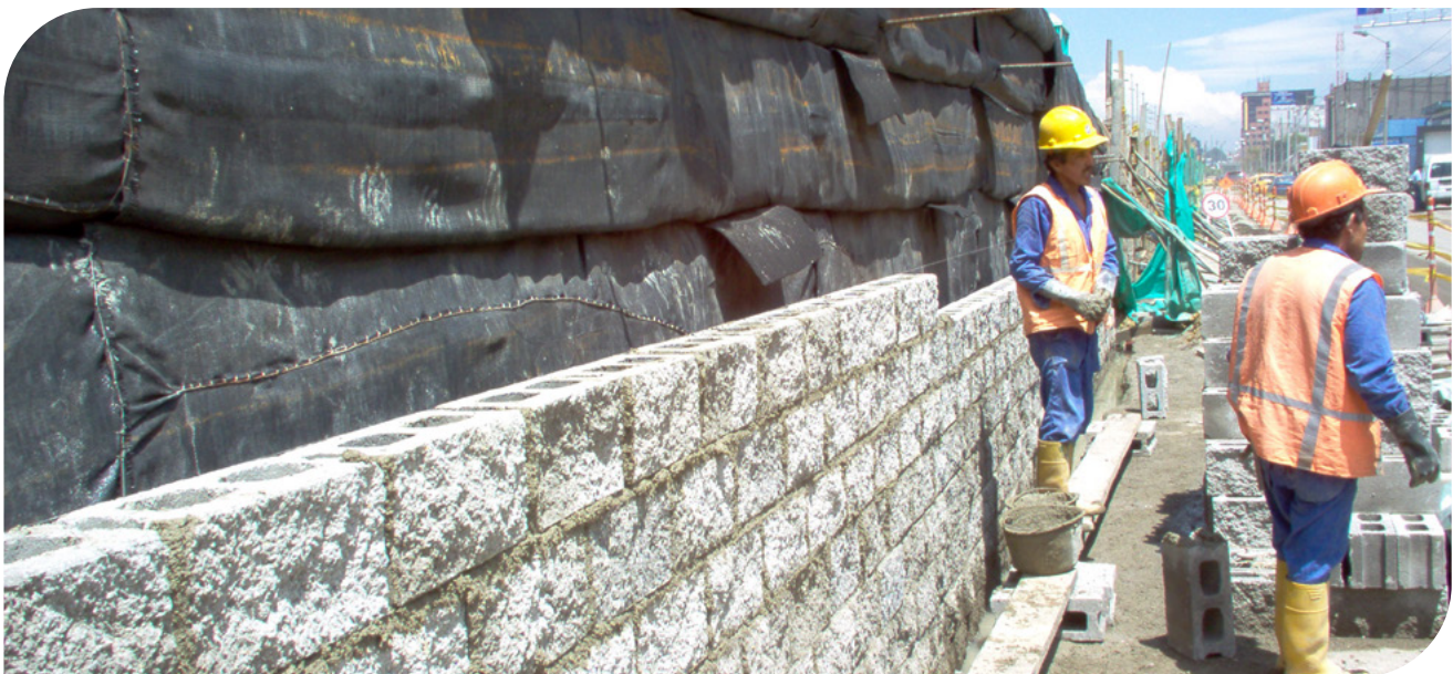
▲ Fotografía 11.9 | Fachada en paneles prefabricados de concreto, como estructura independiente del muro en suelo reforzado con Geotextil.
