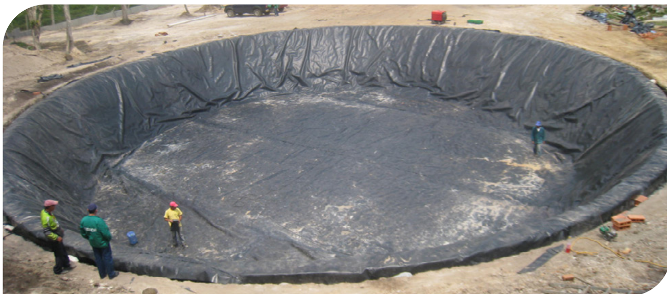
▲ Reservorio la Quinta del Puente | Santander 2011.
