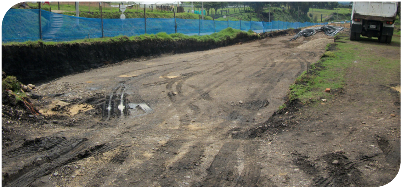
▲ Figura 4.10 | Subrasante blanda para la construcción de la estructura de pavimento.
