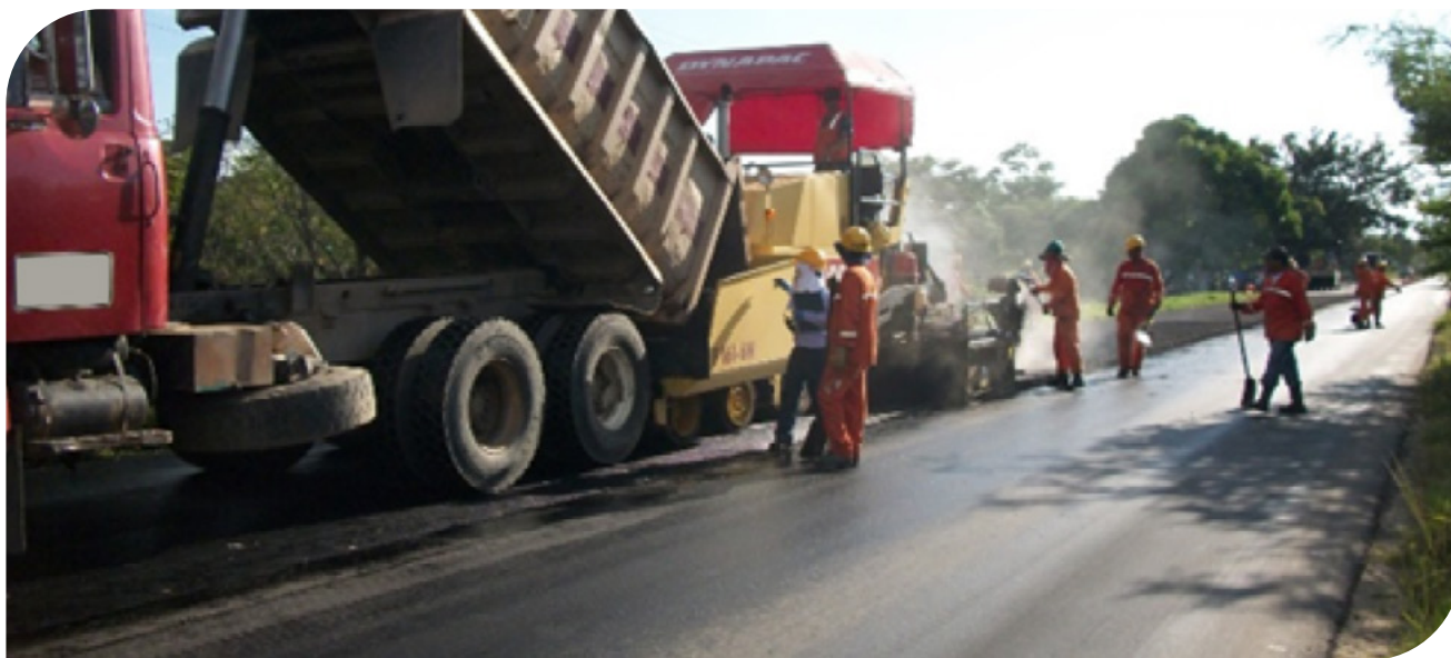
▲ Imagen 8.44 | Repavimentación con Geomalla de Fibra de Vidrio. Proceso continuo y simultáneo.
