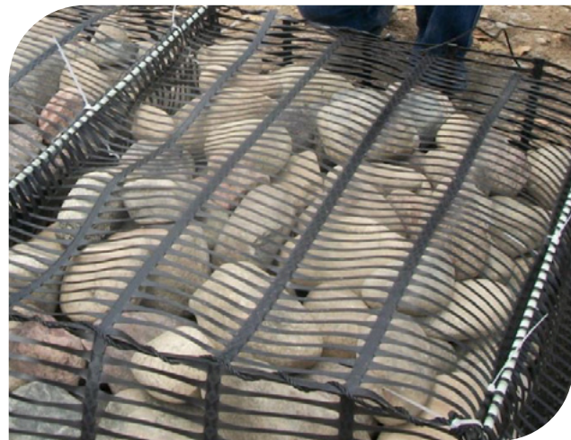
▲ Fotografías 17.32 a 17.35 | Ensamble final mediante manila, varillas y bandas plásticas.
