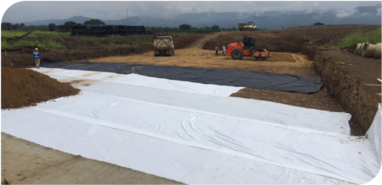
▲ Fotografía 11.13 | Plataforma de Transferencia de Cargas y Refuerzo de Cimentaciones con Geotextiles Tejidos HR.
