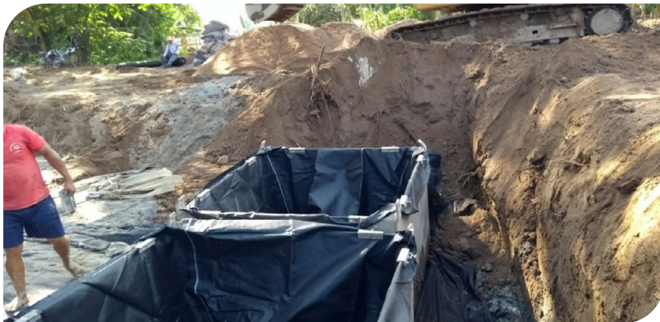
▲ Fotografía 17.12 | Formaleta y apertura de Geobox para llenado.
