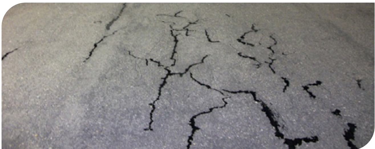
▲ Imagen 8.31 | Sellado de grietas. Aeropista, Colombia.
