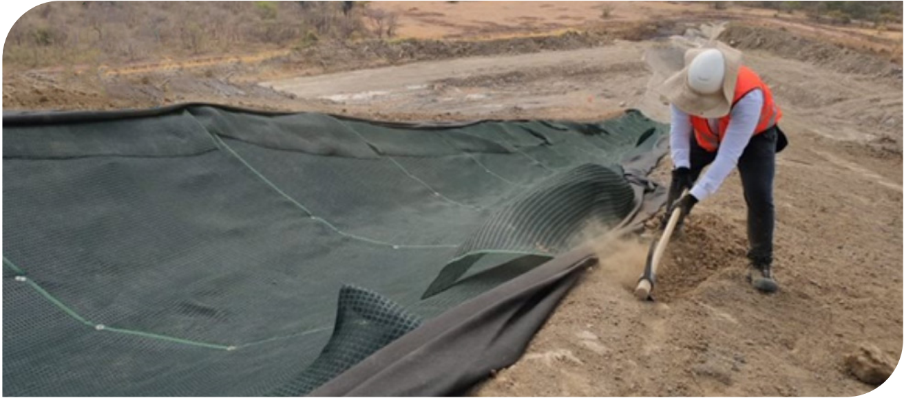
▲ Fotografía 16.9 | Avance solución G-Green en canales.
