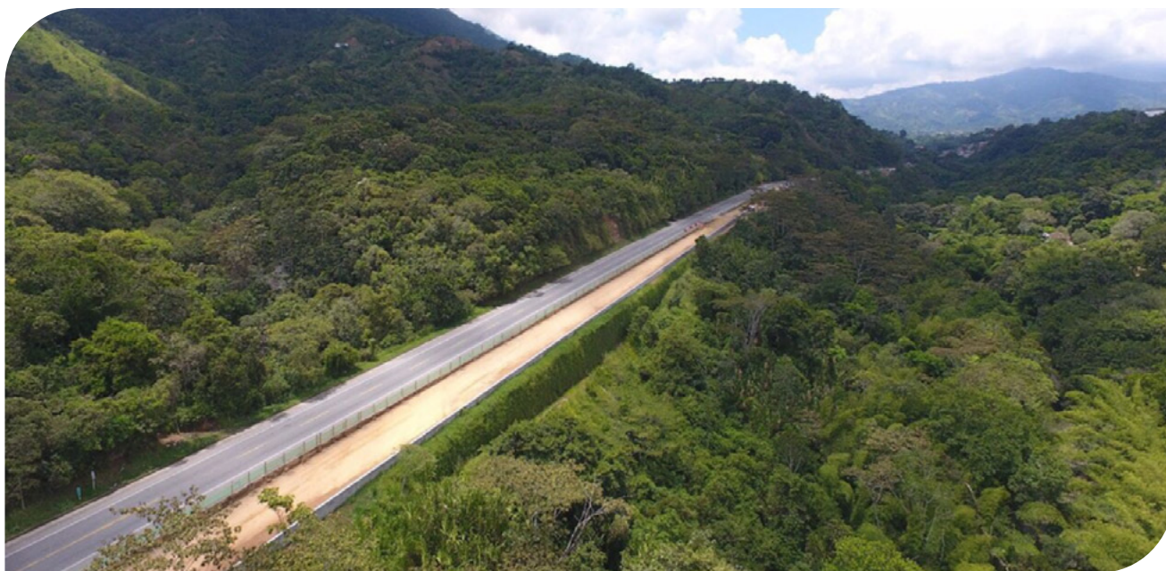
▲ Fotografía 11.3 | Diseño y Construcción Muro en Suelo Reforzado, APP GICA, Ibagué-Tolima-Colombia.
