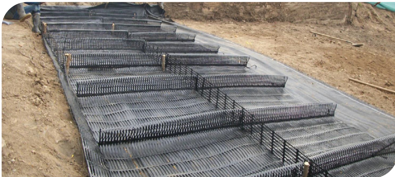
▲ Fotografía 17.30 | Conformación de diafragmas y tapas laterales.
