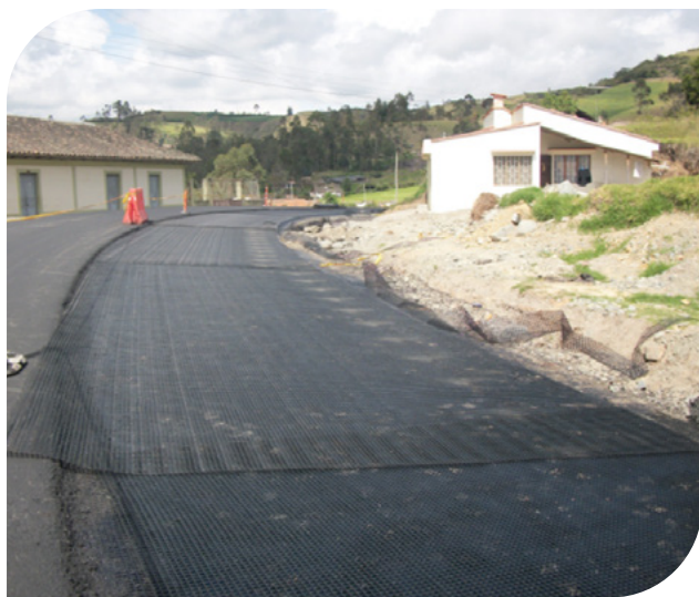
▲ Imagen 8.42 | Instalación de Geomalla en curva en fase de recorte.
