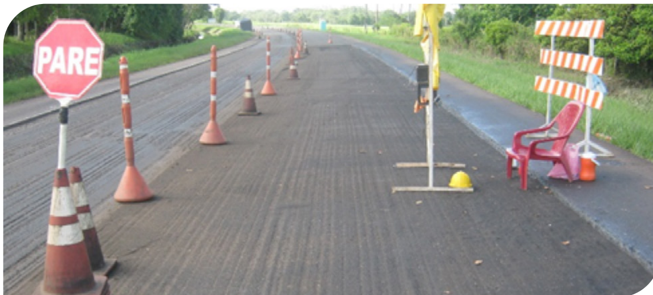
▲ Imagen 8.29 | Repavimentación. Calcado de superficie fresada con Geotextil Repav de Repavimentación saturado. Concesión Autopistas de los Llanos, Colombia.
