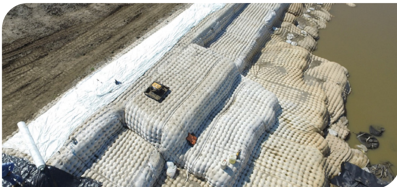
▲ Fotografía 17.4 | Protección superficial con Flexocreto.
