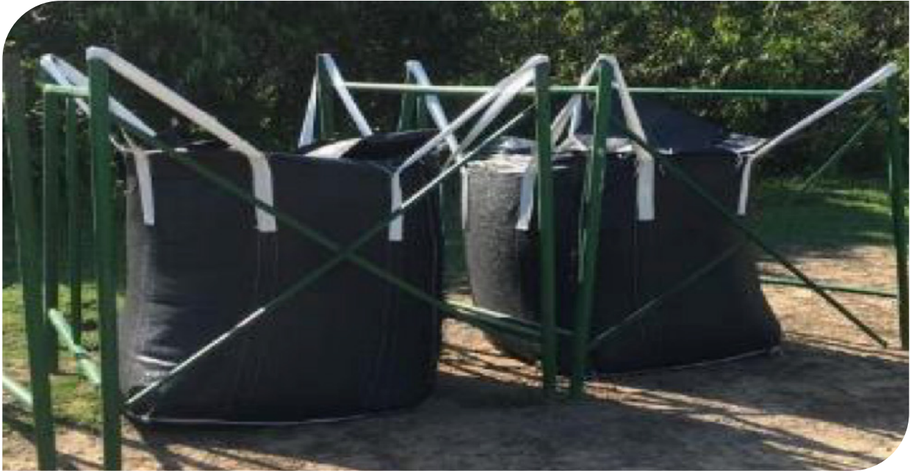
▲ Fotografía 17.5 | Sostenimiento de Geobags con Andamios.
