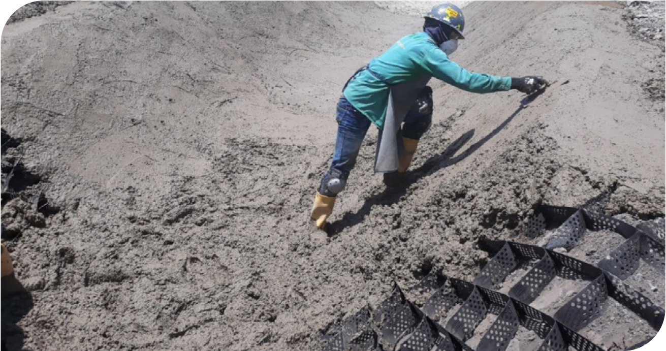
▲ Fotografía 17.52 | Relleno con material de Concreto.
