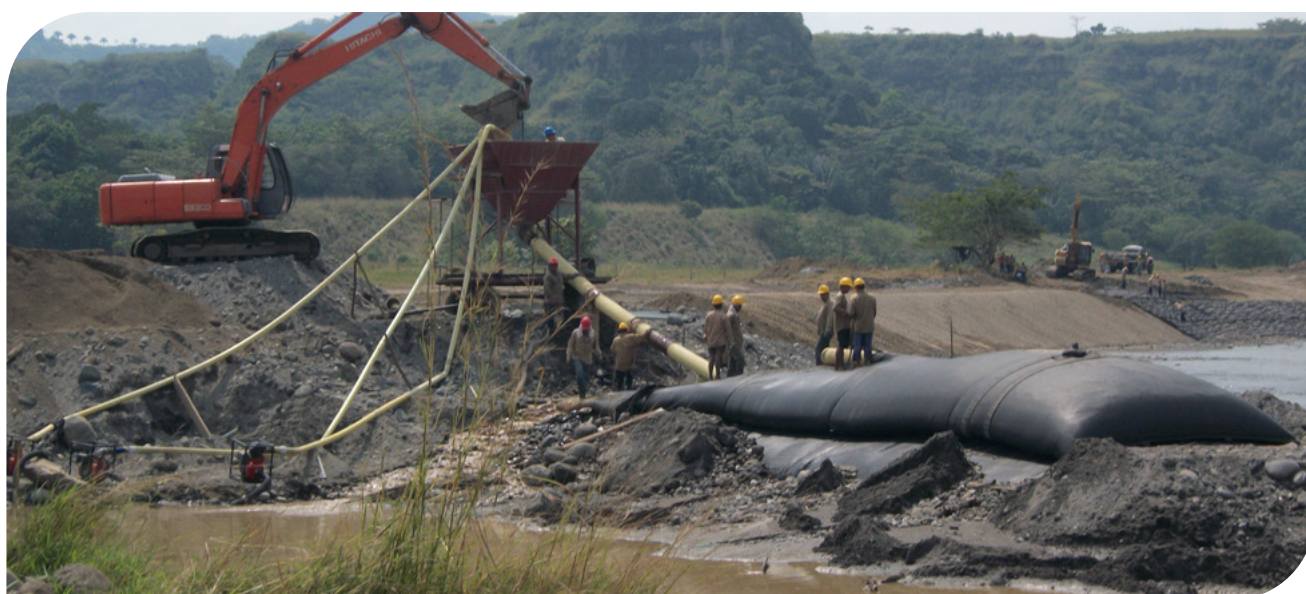
▲ Fotografía 17.18 | Llenado de Geotextile Tubes por gravedad.
