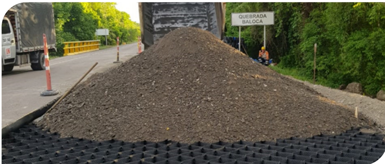
▲ Imágen 7.5 | Material de lleno mezcla de RAP y material granular. Autovía Neiva Girardot, Colombia.
