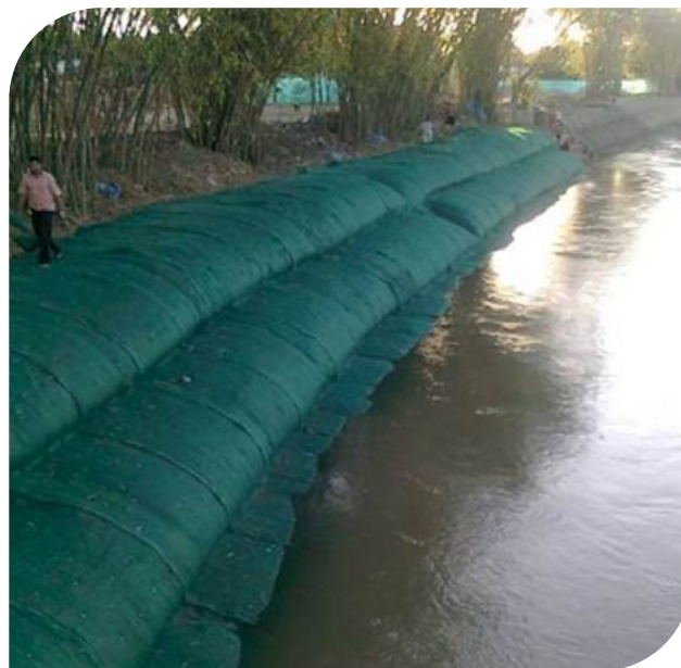
▲ Fotografías 17.21 - 17.22 | Geotextile Tubes protegidos con manto para control de erosión.
