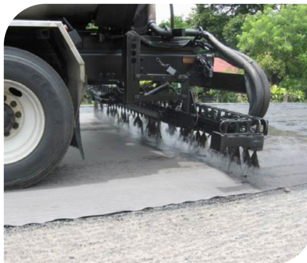
▲ Imagen 8.33 | Instalación manual de los rollos de Geotextil de Repavimentación. ▲ Imagen 8.34 | Paso de irrigador sobre el Geotextil para segundo riego.
