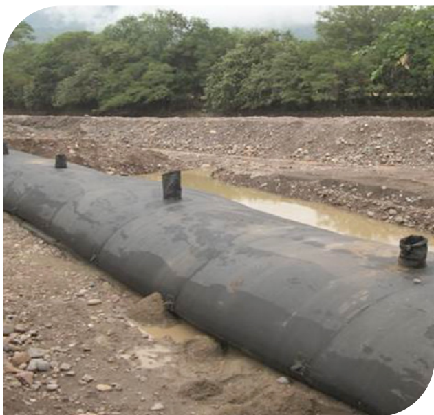
▲ Fotografías 17.23 - 17.24 | Geotextile Tubes instalados.
