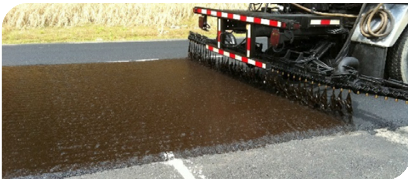
▲ Imagen 8.32 | Riego de emulsión con equipo irrigador-dosificador. Costa Rica.
