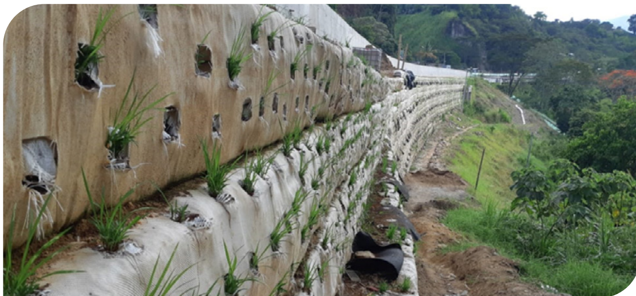
▲ Fotografía 11.12 | Fachada protegidas con Mantos Permanentes TRM.
