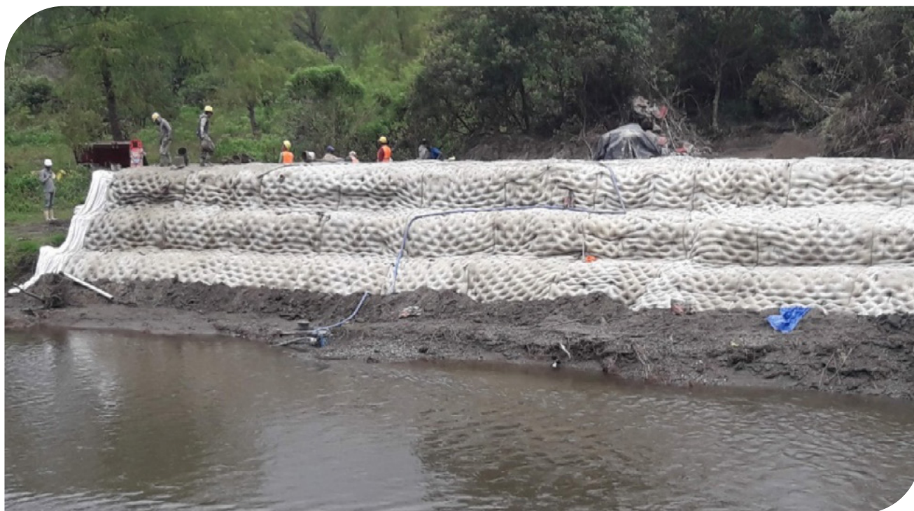
▲ Fotografía 17.16 | Fachada con Flexocreto.
