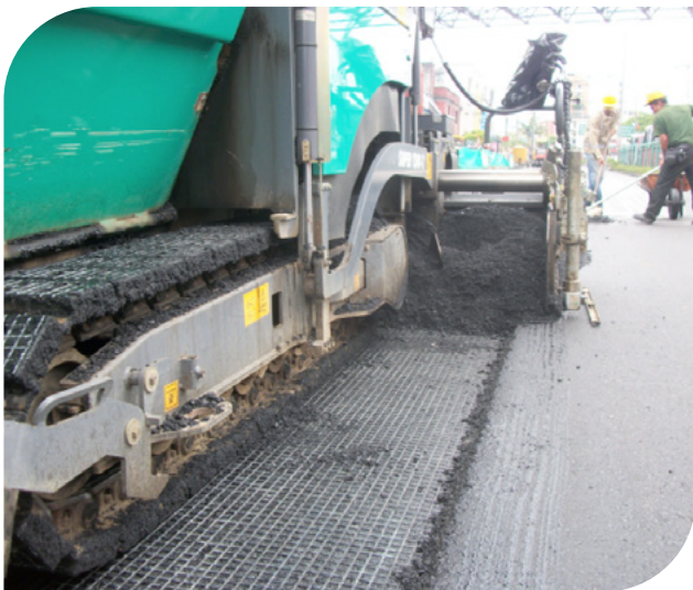
▲ Imagen 8.17 | Repavimentaciones con Geomalla de Fibra de Vidrio, Carrera 14 Armenia. Imagen 8.18 | Pista de aeropuerto Alfonso Lopez Pumarejo Valledupar.
