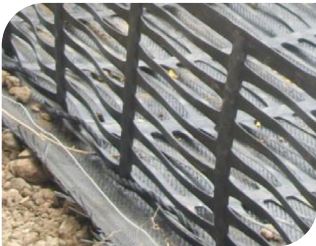
▲ Fotografías 17.32 a 17.35 | Ensamble final mediante manila, varillas y bandas plásticas.
