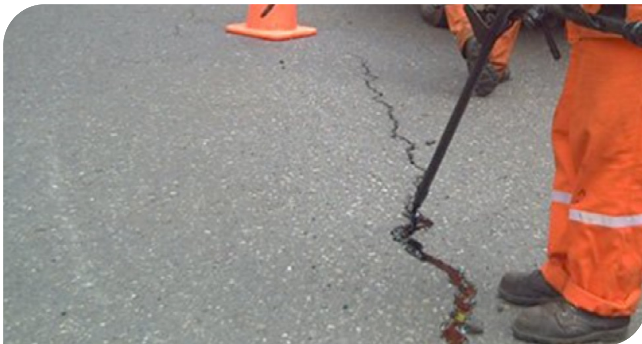
▲ Imagen 8.38 | Sellado de fisuras.
