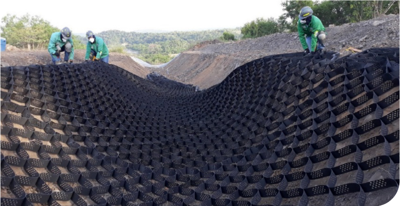
▲ Fotografía 17.44 | Protección de un canal con Geocelda.
