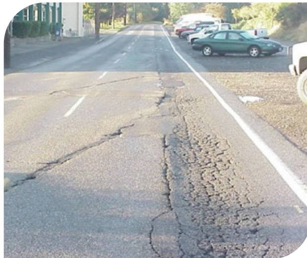
Imagen 8.2 | Piel de cocodrilo acompañada de ahuellamiento (der.) Severidad alta. 1
