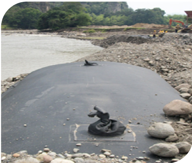
▲ Fotografía 17.19 | Detalle de cerradura de puerto. ▲ Fotografía 17.20 | Modo de costura.
