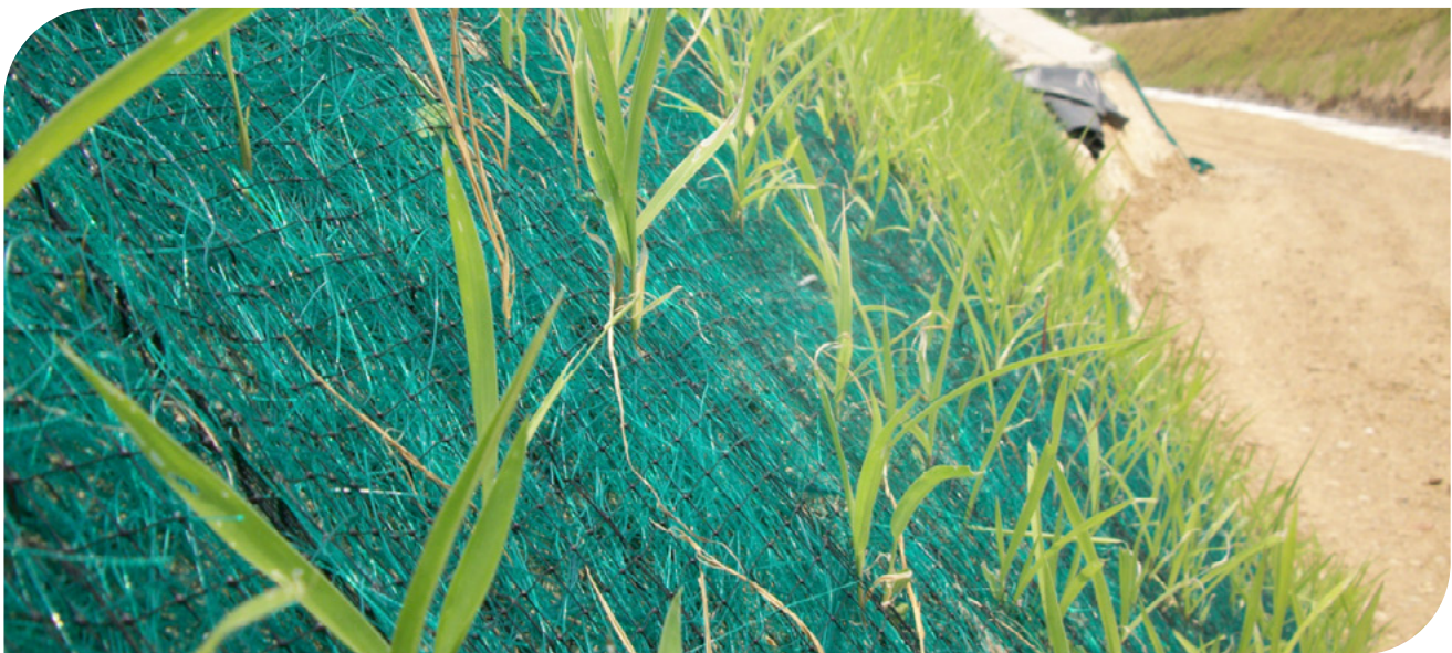
▲ Revegetación talud con Manto Permanente TRM | Vía Ruta del Sol Sector 2 Km 75, Colombia.
