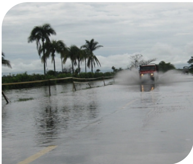
▲ Imagen 8.21 | Corredor vial con lámina de agua sobre rasante que requiere Geotextil saturado para impermeabilidad.
