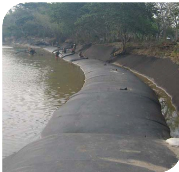
▲ Fotografías 17.21 - 17.22 | Geotextile Tubes protegidos con manto para control de erosión.
