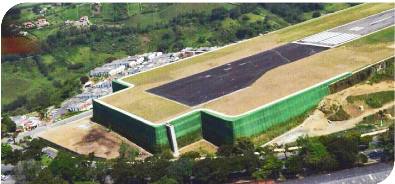
▲ Fotografía 11.5 | Diseño y Construcción Muro en Suelo Reforzado, Aeropuerto de Matecaña, Pereira – Risaralda - Colombia.
