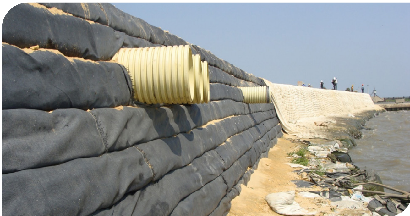
▲ Fotografía 17.60 | Cuerpo del Geoland Mediante Muro en suelo Reforzado en el Centro de Eventos y Exposiciones del Caribe Puerta de Oro, Barranquilla Atlántico – Colombia, construido por el Consorcio Obras CEEC 2015.
