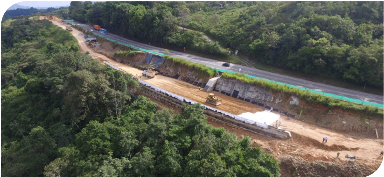
▲ Fotografía 11.6 | Construcción Muro en Suelo Reforzado APP GICA, Ibagué – Tolima, sección crítica H: 11.7m, K2+406.
