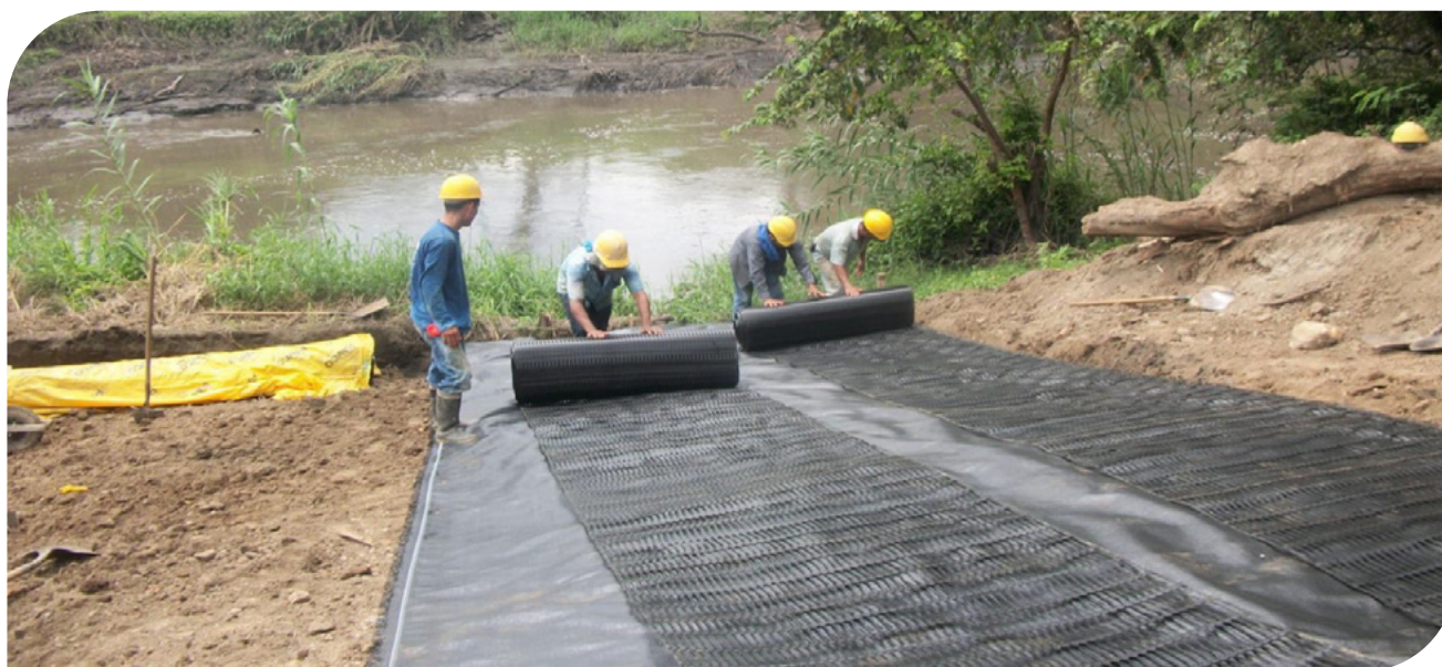
▲ Fotografía 17.29 | Extendido de Geomalla sobre Geotextil No Tejido.
