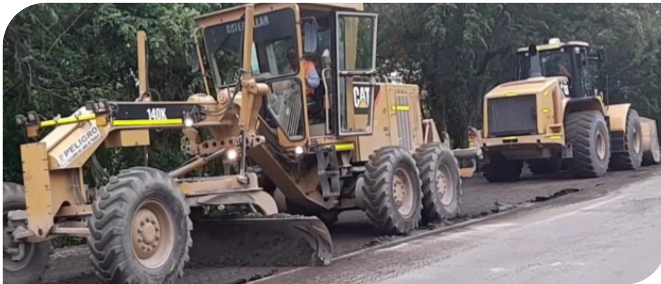
▲ Imágen 7.6 | Equipos para extensión y compactación. Autovía Neiva Girardot, Colombia.
