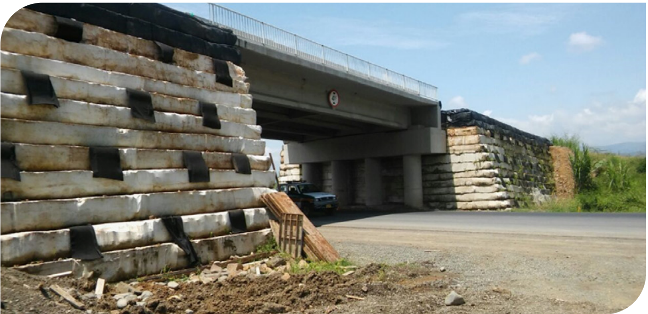
▲ Fotografía 11.14 | Muro en Suelo Reforzado Diseñado y Construido Bajo Metodología WSD.
