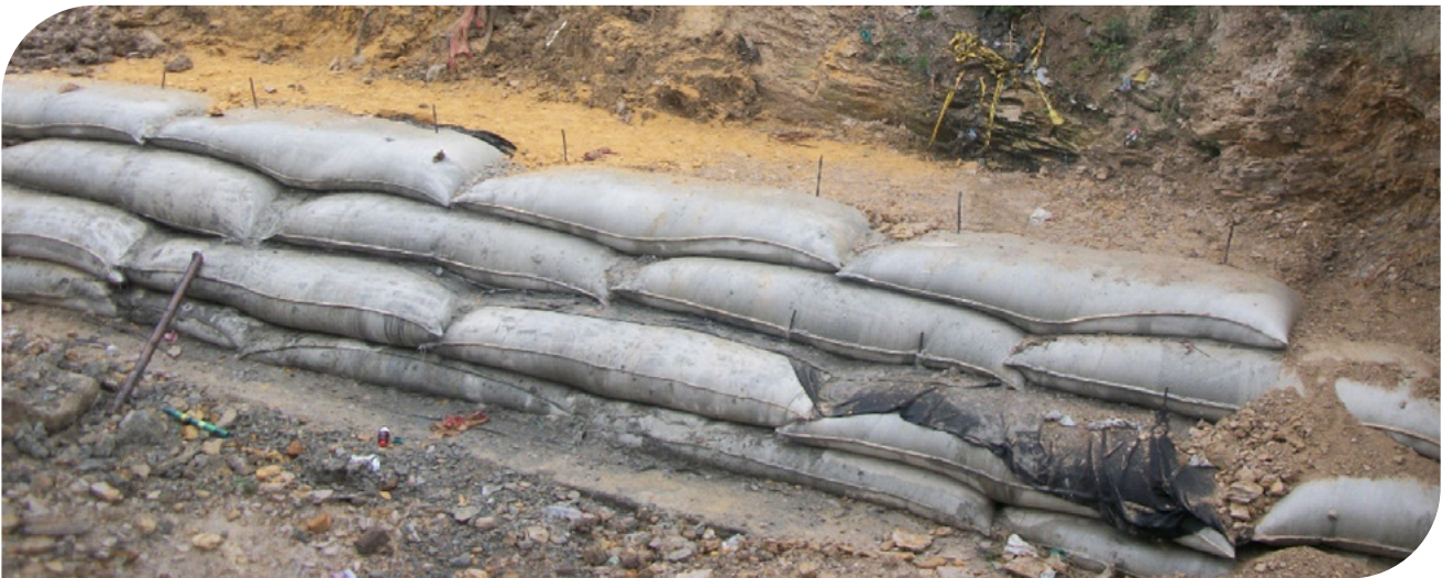
▲ Fotografía 17.36 | Articulación de Bolsacretos con varillas de acero.
