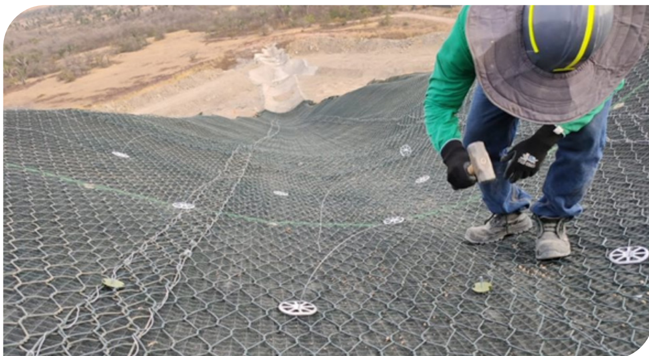
▲ Fotografía 16.5 | Malla talud en sistema G- Green.
