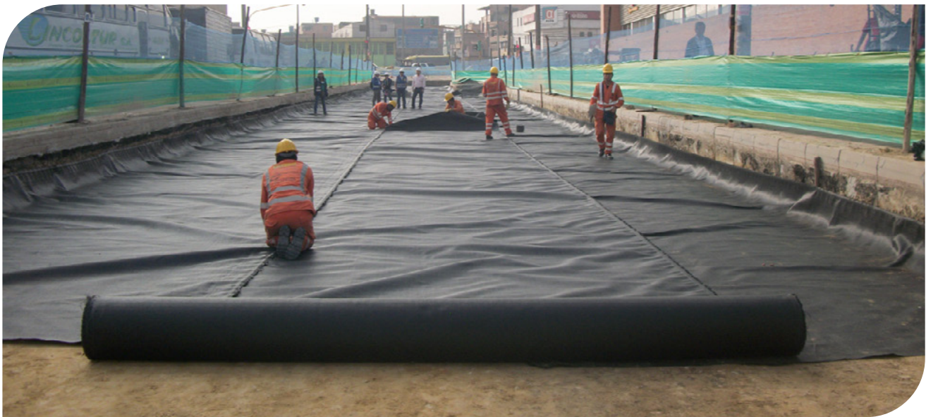
▲ Separación y estabilización con Geotextil Tejido | Vía Patio Bonito, Bogotá, Colombia.
