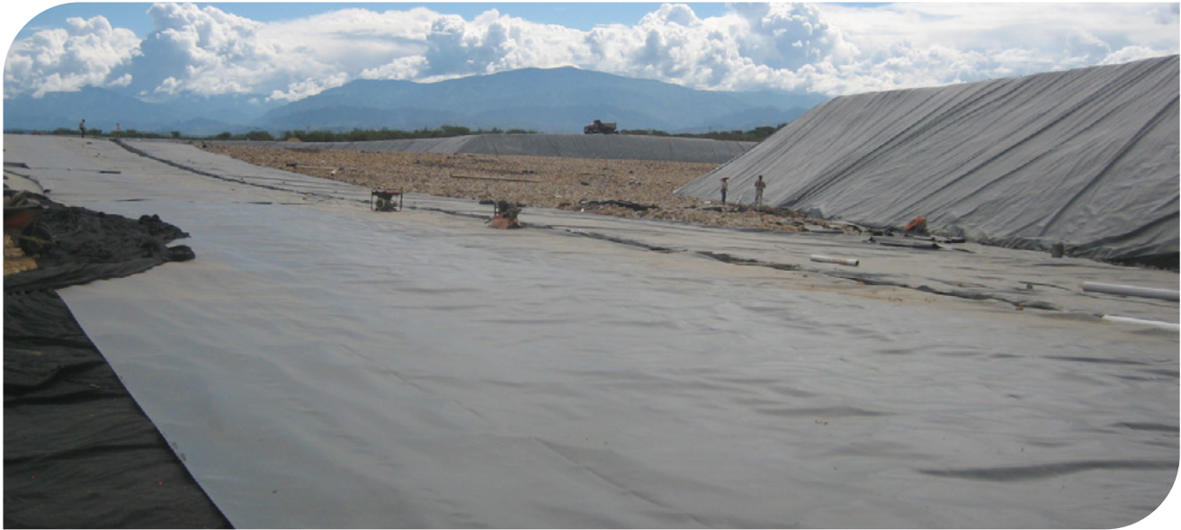
▲ Impermeabilización relleno sanitario con Geomembrana HDPE | Relleno Sanitario Lo Ángeles, Neiva, Colombia.
