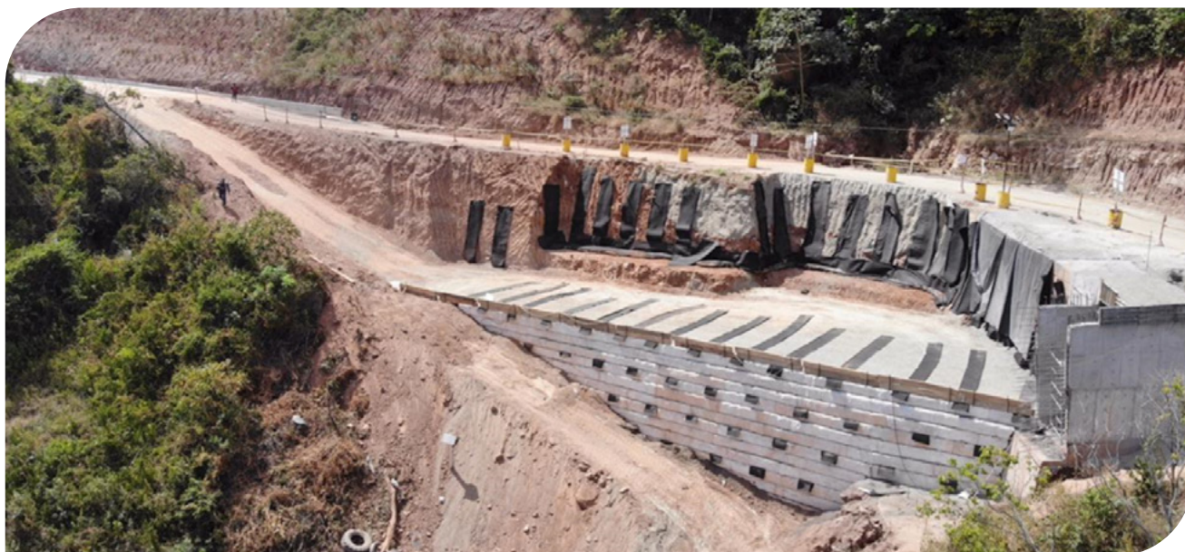
▲ Fotografía 11.8 | Instalación lloraderos de Geodrén Planar, Muro en Suelo Reforzado Gualanday.
