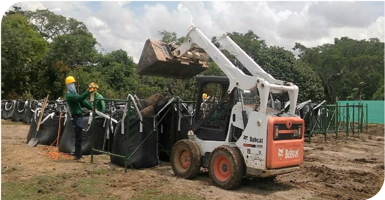
▲ Fotografía 17.6 | Llenado de Geobags con minicargador.
