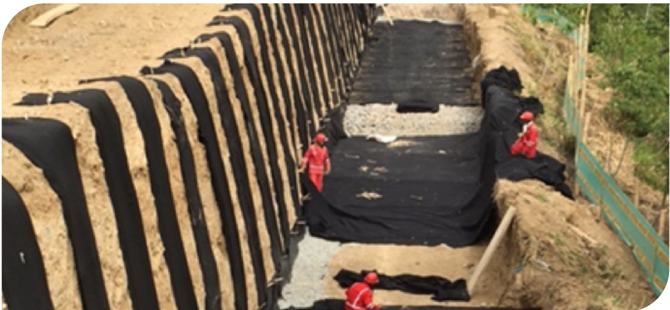
▲ Fotografía 11.7 | Construcción Colchón Drenante y filtro en el espaldón, Muro en Suelo Reforzado ALMA.
