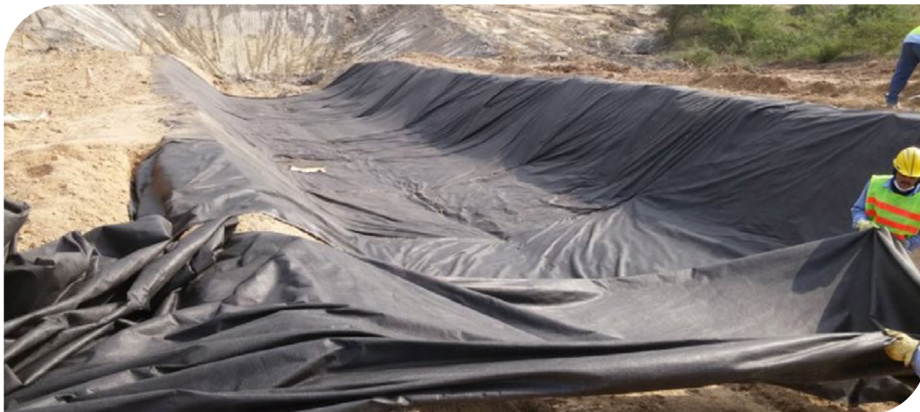
▲ Fotografía 17.47 | Instalación del Geotextil.
