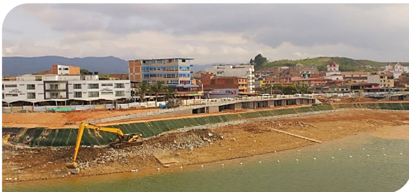
▲ Fotografía 17.55 | Fachada Verde para Geoland del Malecón turístico de Guatapé Antioquia – Colombia construido por la Unión Temporal Obras Guatapé.
