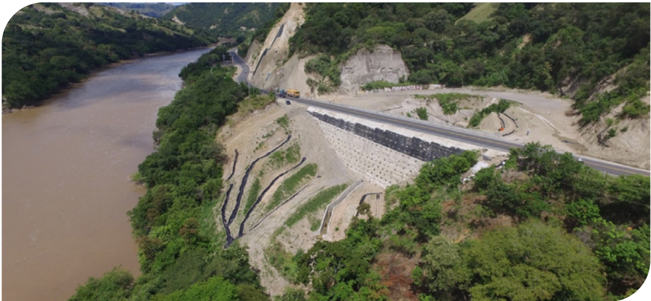
▲ Fotografía 11.1 | Muro en Suelo Reforzado, Concesión ALMA, Honda-Tolima-Colombia.
