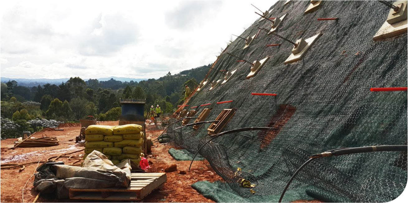
▲ Fotografía 16.12 | Instalación G-Green túnel de oriente.
