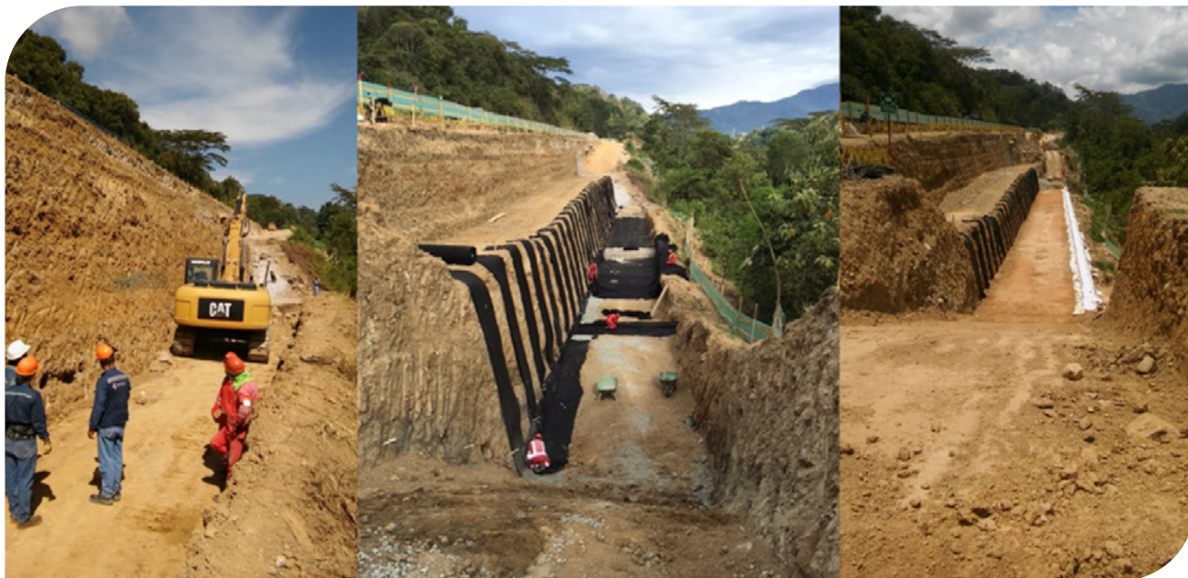
▲ Fotografía 11.2 | Diseño y Construcción Muro en Suelo Reforzado, APP GICA, Ibagué-Tolima-Colombia.
